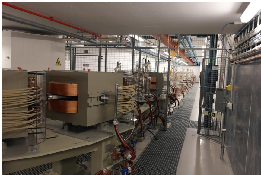
KUVA 4. Siirtojärjestelmän magneettikeloja (Kauppinen 2016.)
