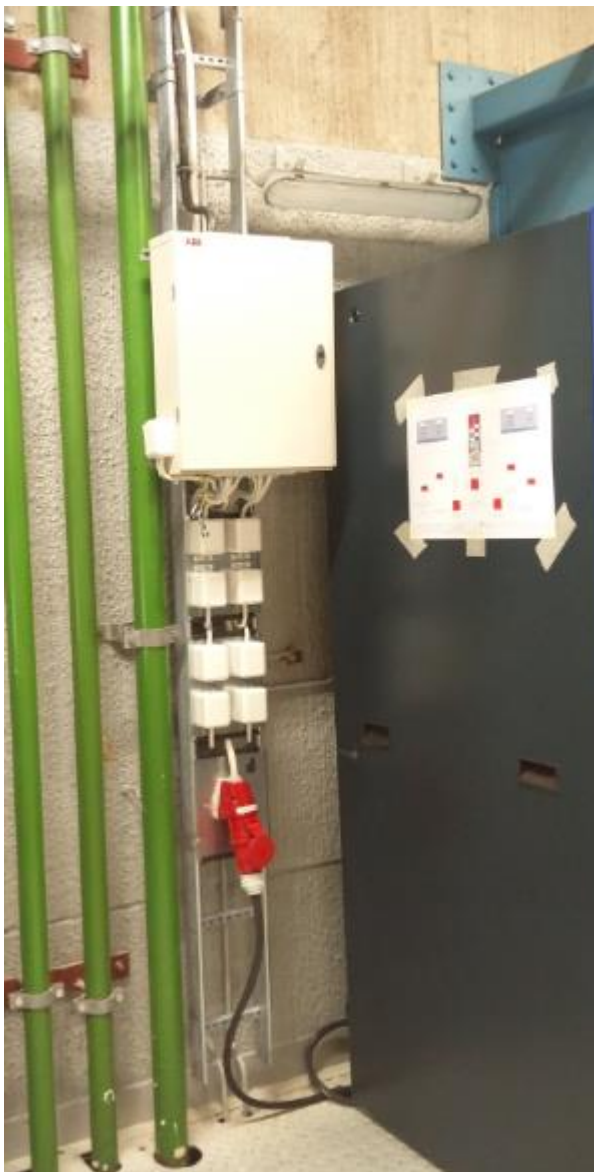
Kuva 6. Sähköjen sijainti laitteen takana.
