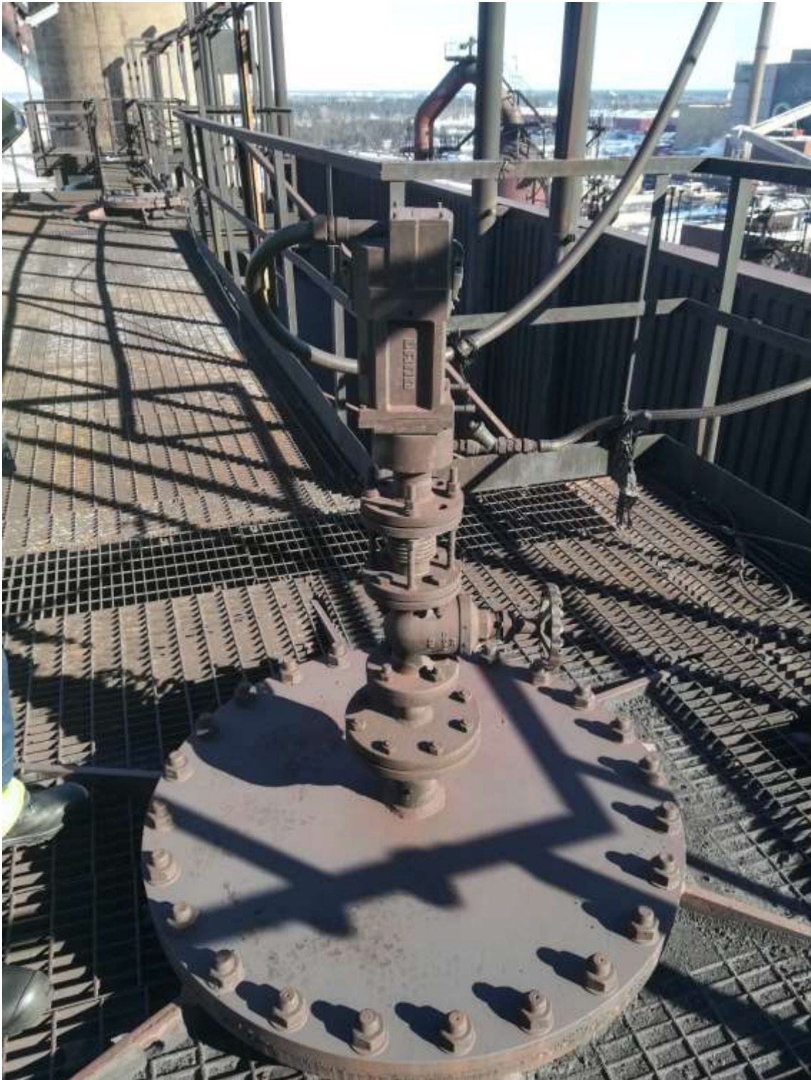
KUVA 19. Cowperin sisälle kuvaava pyrometri.
