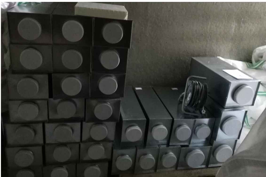
Kuva 3. Työmaalle varastoidut ilmanvaihdon äänenvaimentimet
