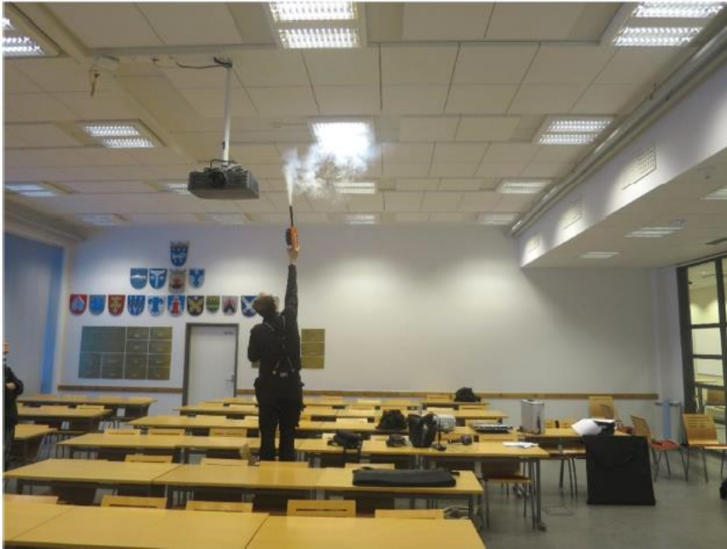
KUVA 3. Savukoneella tehty testi tuloilmalaitteen ilmanjaosta (16, s.17)
