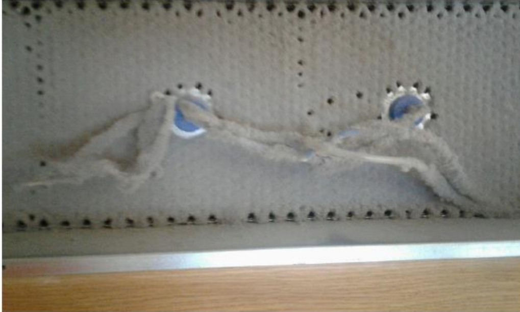
KUVA 2. Poistoilmaventtiin liikaantunut paineenalennuspelti (12, s.4)
