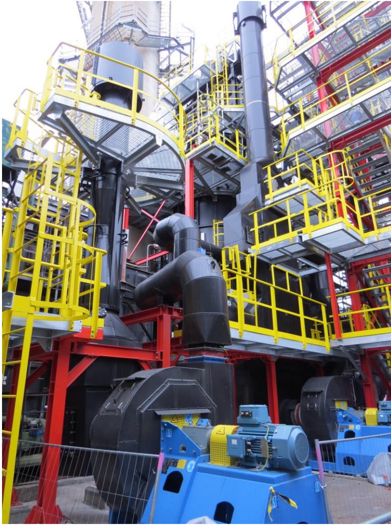
Kuva 6. Uusi kuumaöljy uuni (Stolt 2017).
