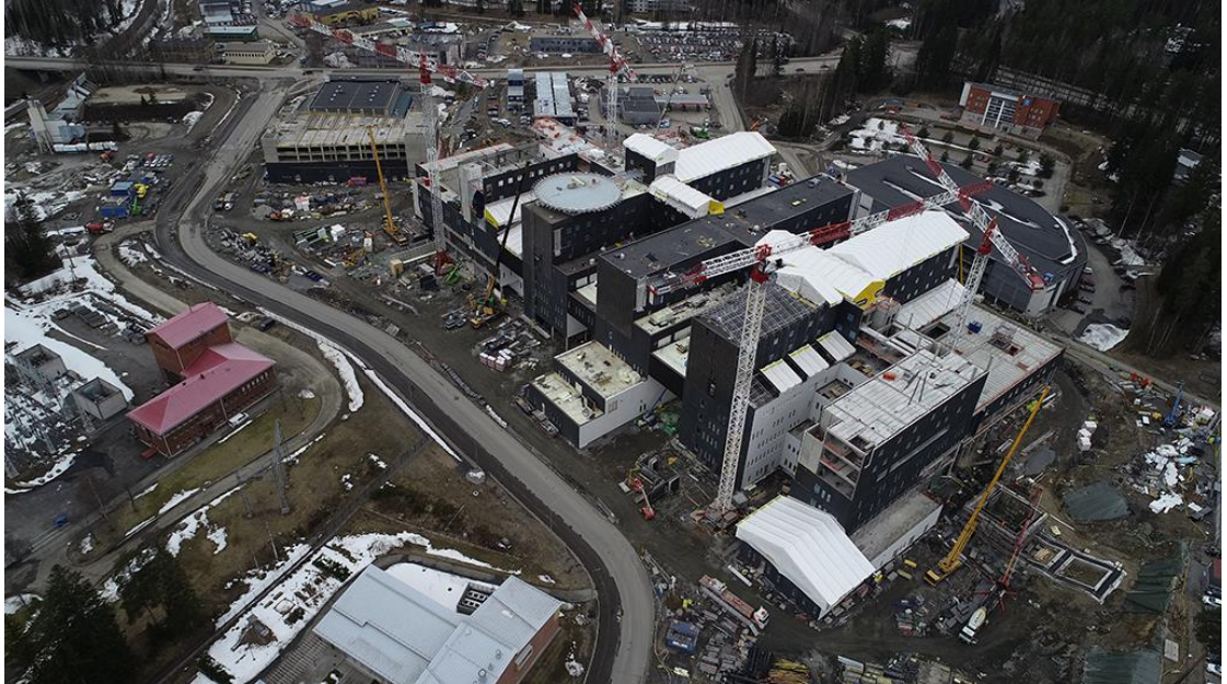
Kuvio 1. Sairaala Novan työmaa (Työmaan tilanne 2018)
