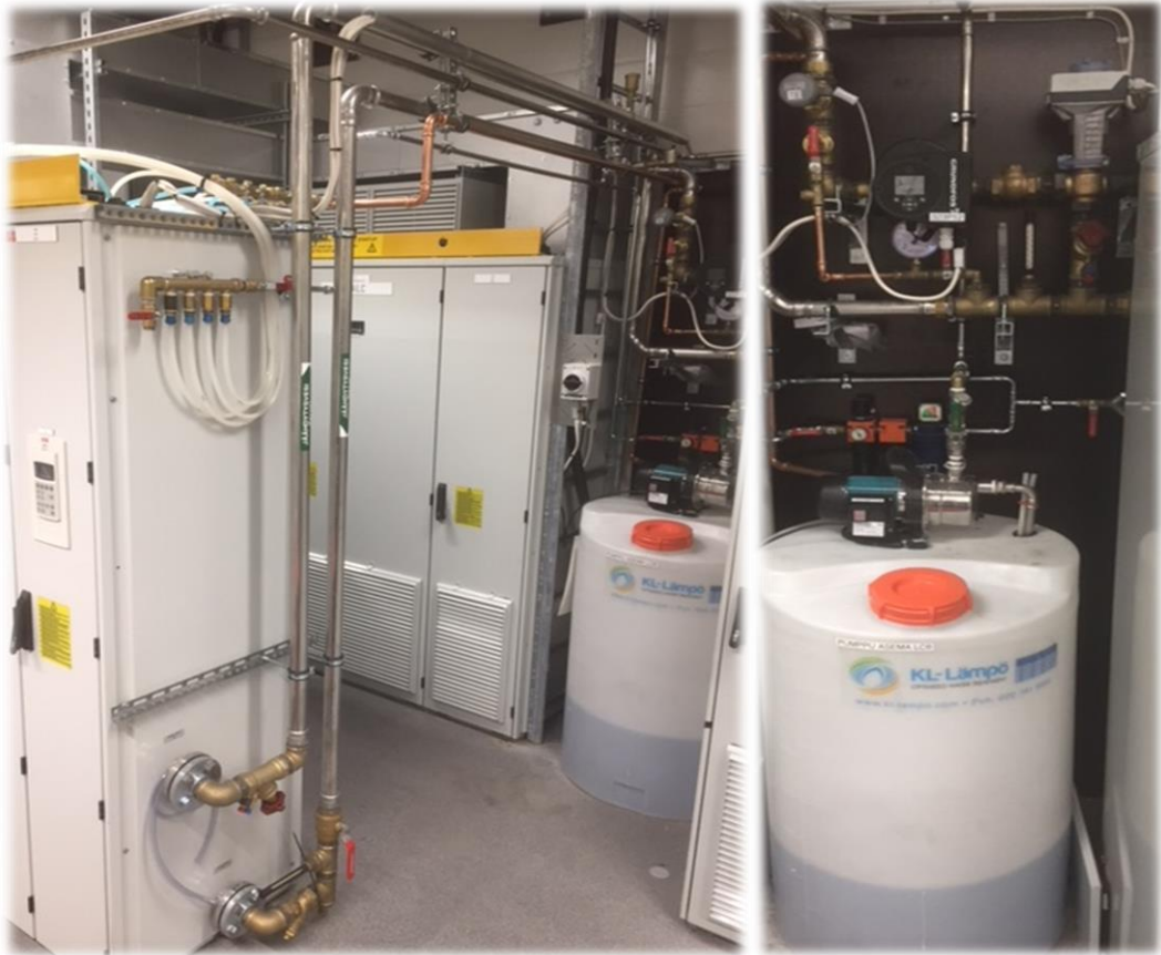
Kuva 12. Valokuvia koestuslinjasta, kuristinkaapista sekä jäähdytysjärjestelmästä
