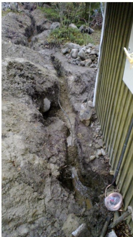
KUVA 5. Sähkökaapelin kanaali rakennukseen (Tuiremo 2014)
