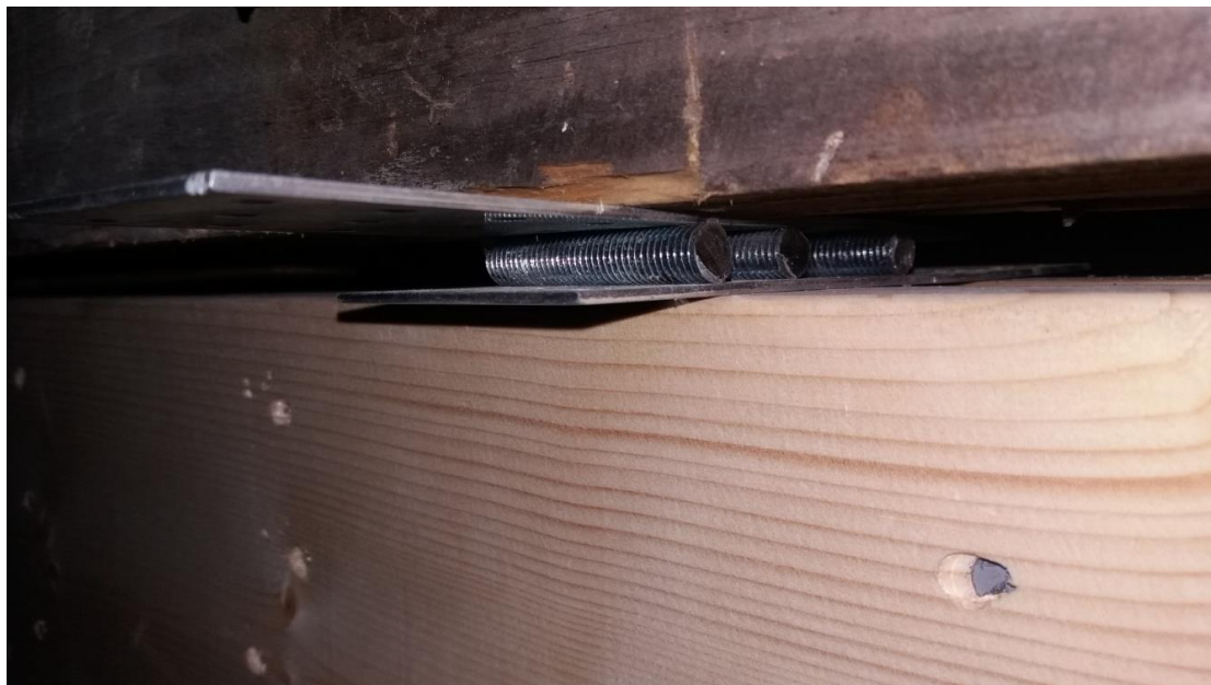
KUVA 10. Vanha alajuoksu kohdistetaan tarkasti uuden alapohjapalkiston päälle (Tuiremo 2016)
