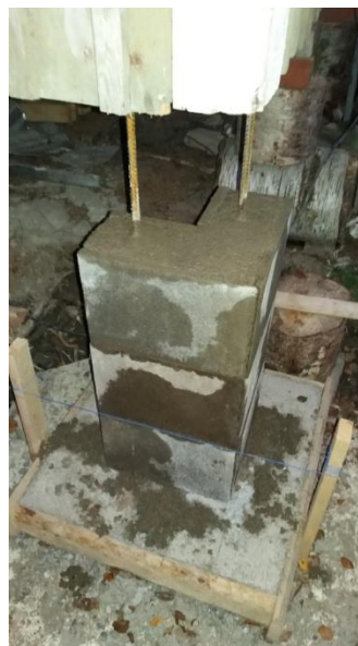
KUVAT 7 ja 8. Pilarianturaperustuksen tekovaihe (Tuiremo 2016)
