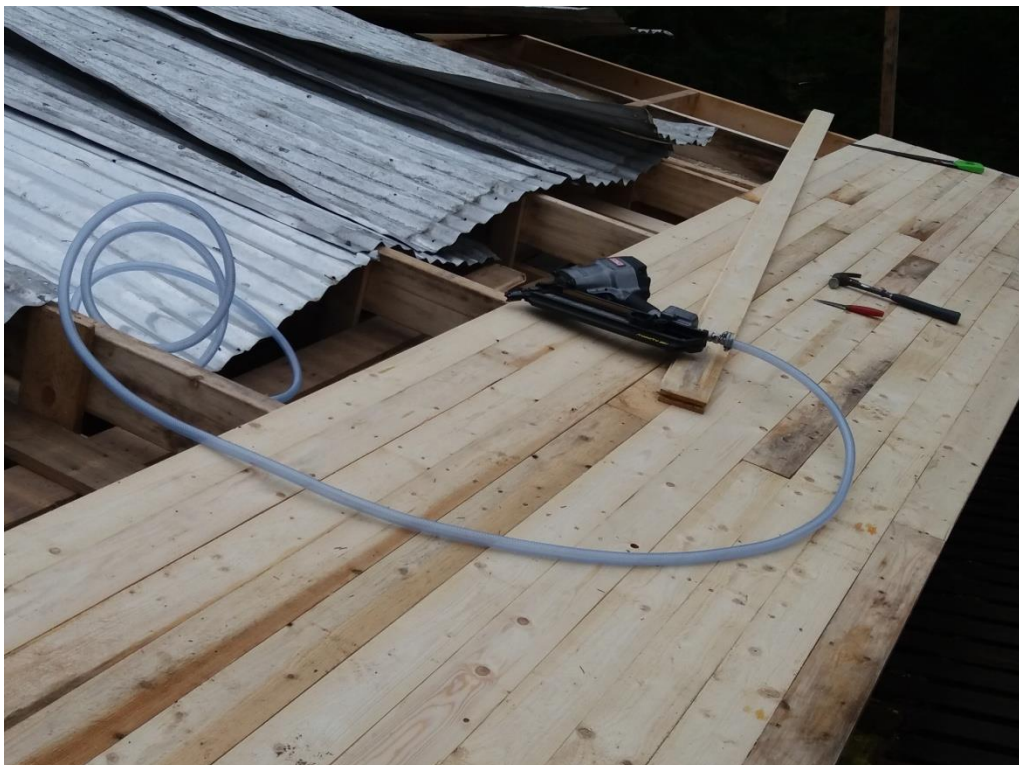
KUVA 15. Huopakatteen alusponttilaudoitus (Tuiremo 2017)
