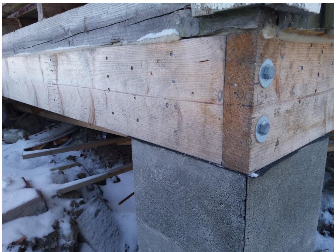
KUVA 9. Palkkikehä vanhan alajuoksun alla (Tuiremo 2018)
