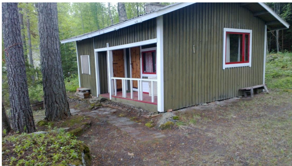
KUVA 1. Rakennus lähtötilanteessa (Tuiremo 2014)
