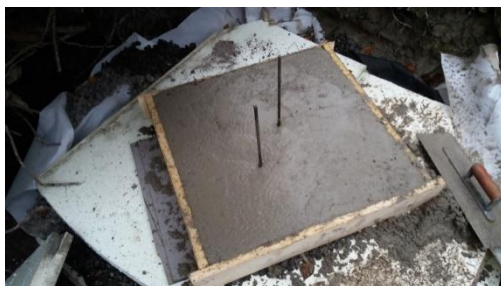
KUVAT 7 ja 8. Pilarianturaperustuksen tekovaihe (Tuiremo 2016)
