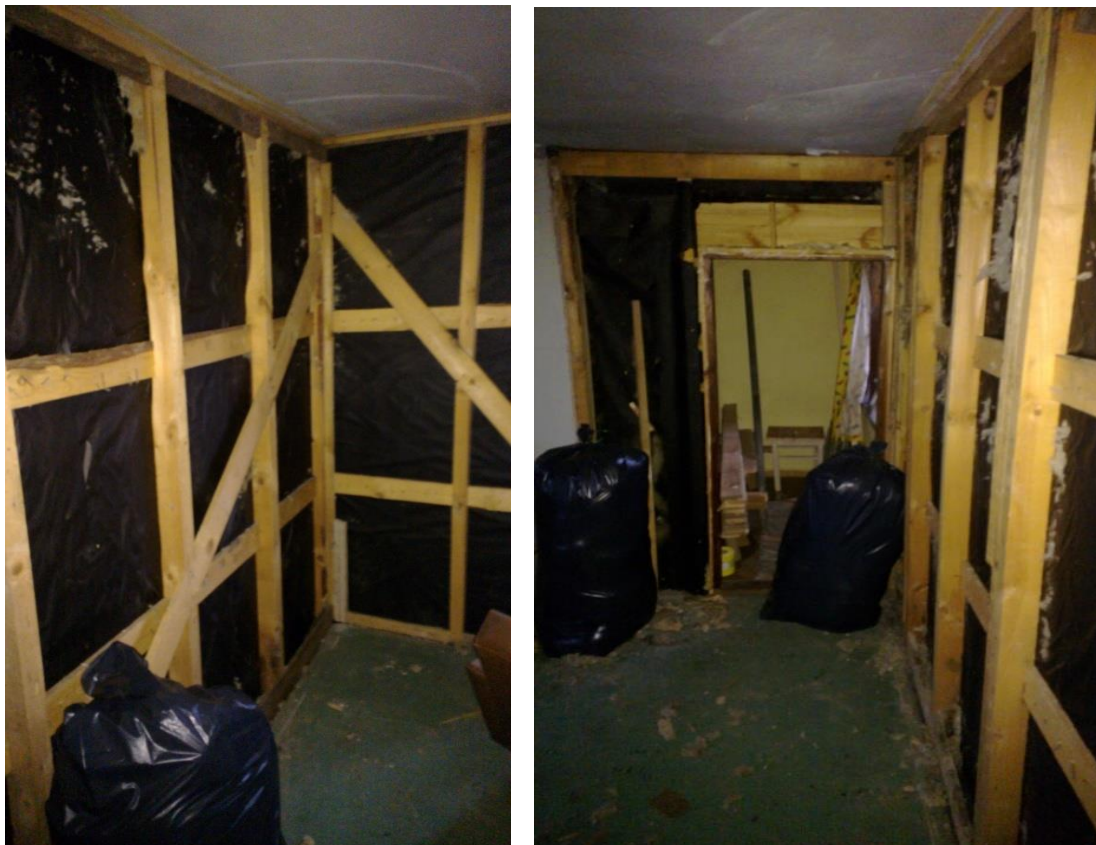
KUVAT 11 ja 12. Ulkoseinän rankarunko ja vinojäykisteet (Tuiremo 2015)
