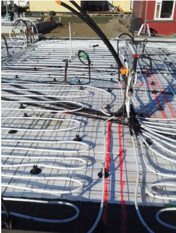
Kuva 16. Esimerkkikohteen alapohjaan tuli paljon tekniikkaa. Kesä 2017.
