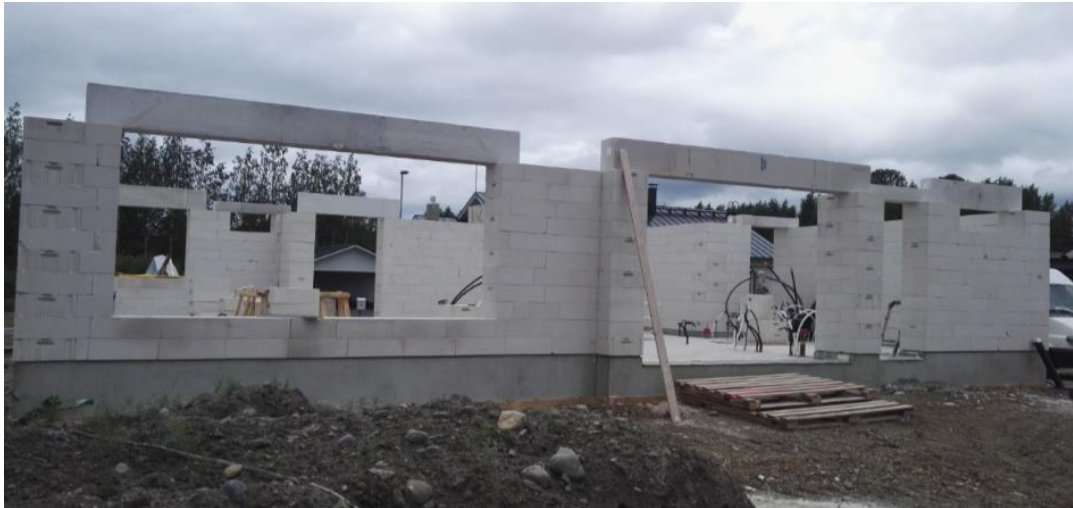
Kuva 21. Ulkoseinien muurausvaihe esimerkkikohteessa. Kesä 2017.
