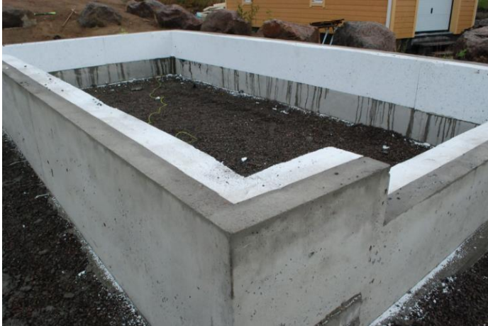
Kuva 6. Paikalla valettu perusmuuri sisäpuolisella lämmöneristeellä. [14]
