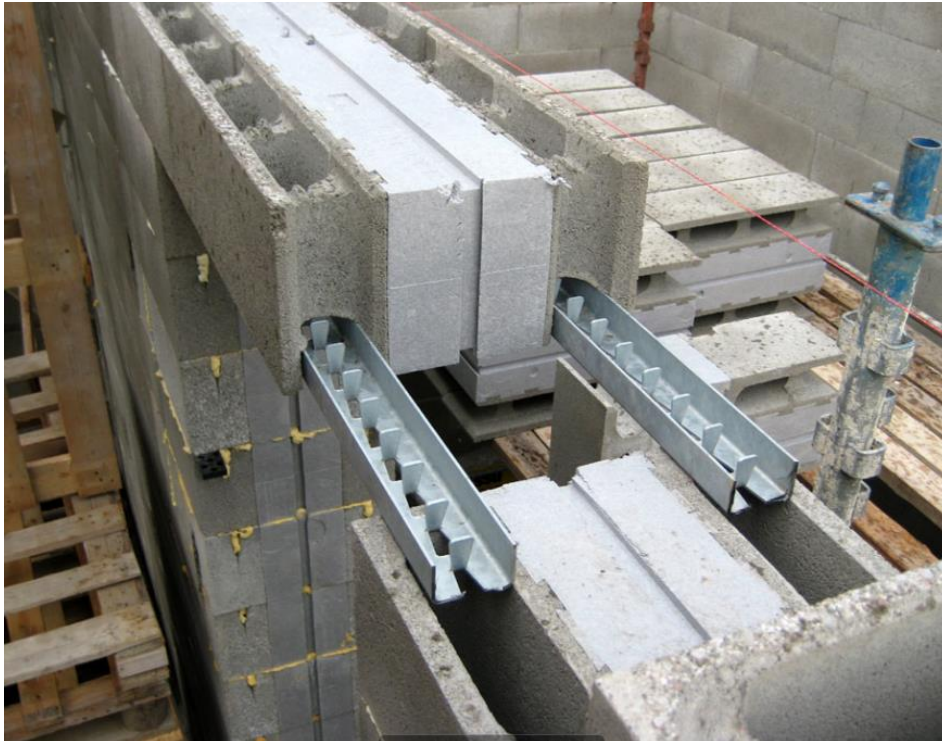
Kuva 20. Aukon ylitys Lammin U-teräksillä. [38]
