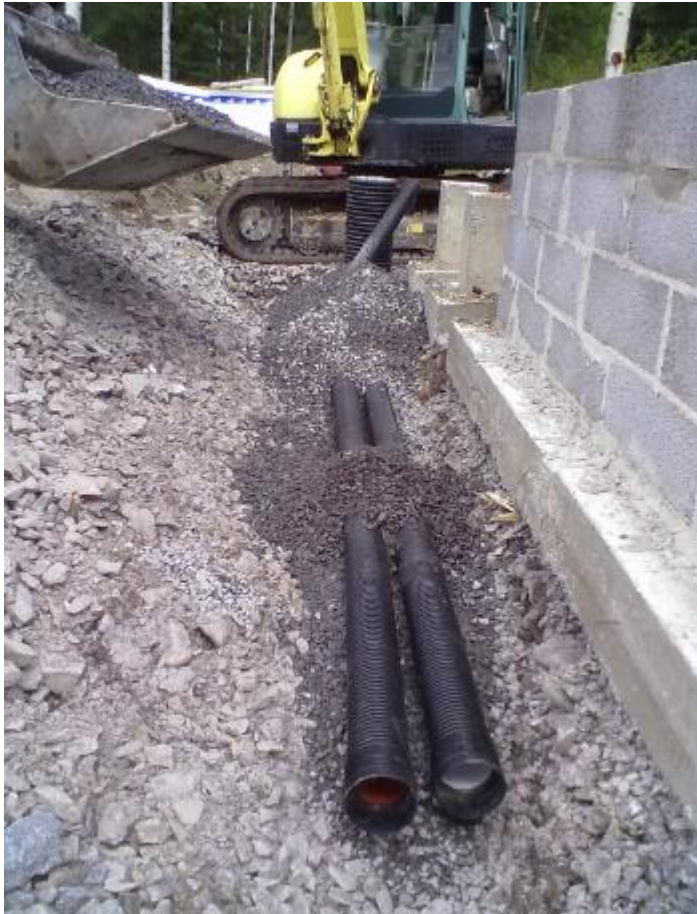
Kuva 2. Sadevesi- ja salaojaputket vierekkäin, ympärille laitetaan salaojatoraa. [43]
