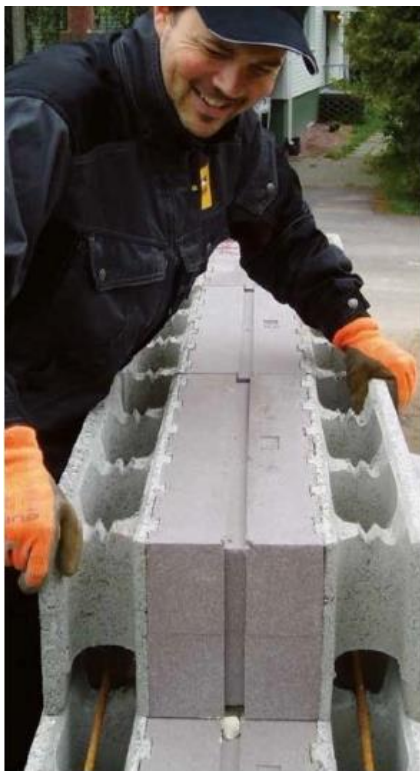
Kuva 12. Sokkelin rakennusta valueristeharkolla. [12]
