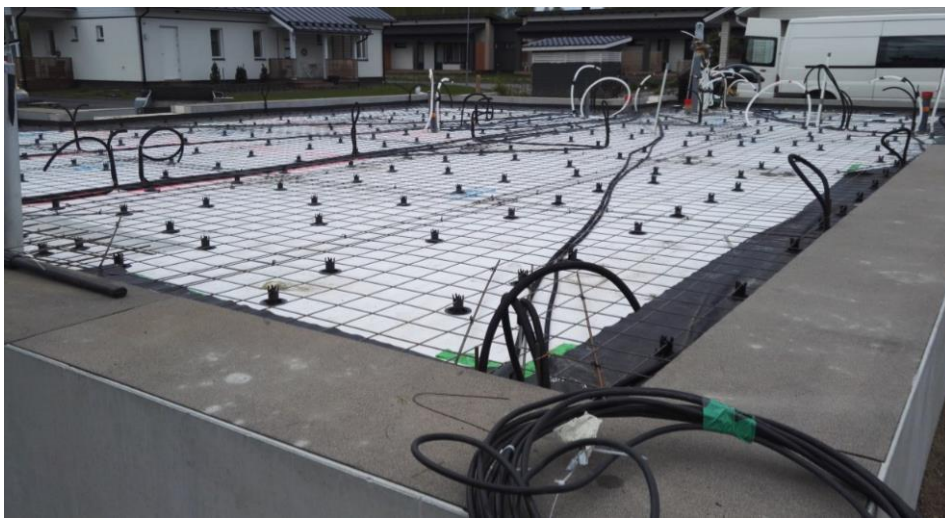
Kuva 14. Esimerkkikohteen maanvarainen alapohja työn alla. Kesä 2017.
