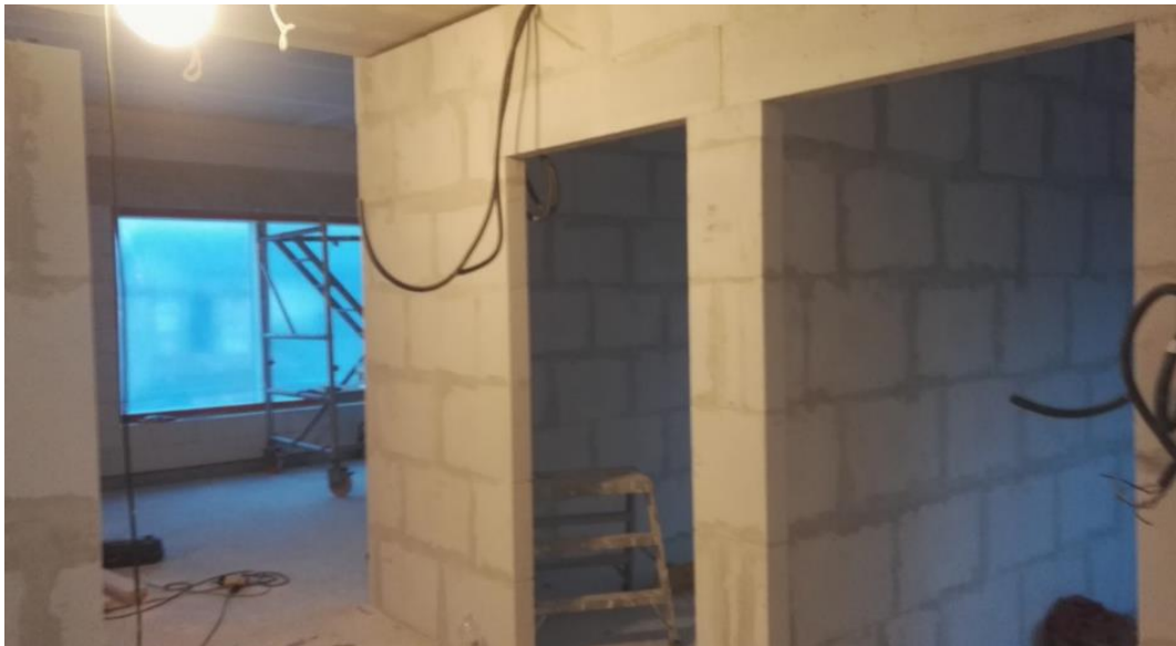
Kuva 30. Kevytbetoniharkoista tehtyjä väliseiniä esimerkkikohteessa. Syksy 2017.
