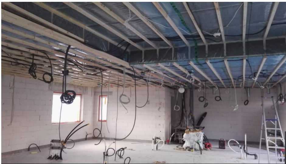
Kuva 27. Esimerkkikohteen höyrysulutettu ja koolattu alakatto. Syksy 2017.
