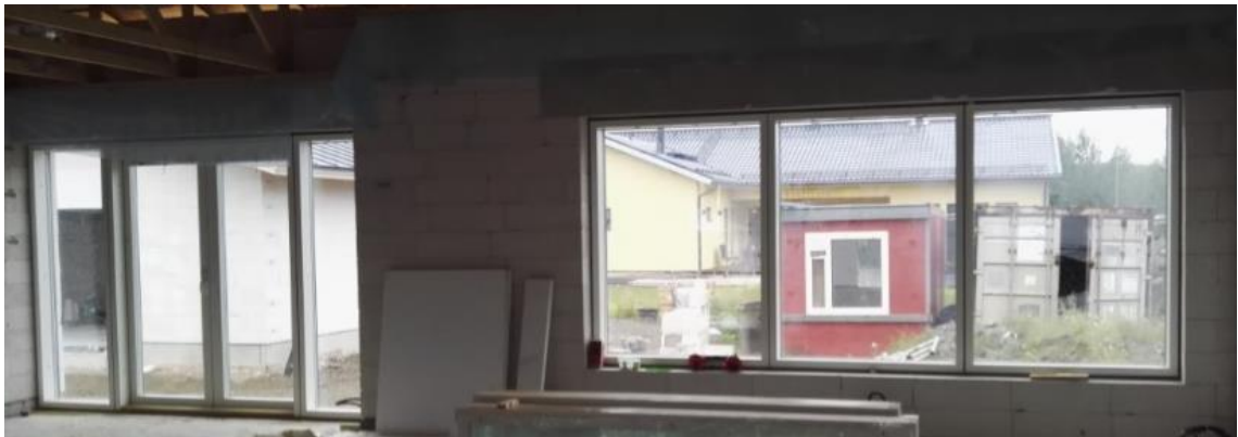
Kuva 32. Ikkuna-aukoista tulee valoa. Kuvan ikkunat ovat kiinteitä. Kesä 2017.
