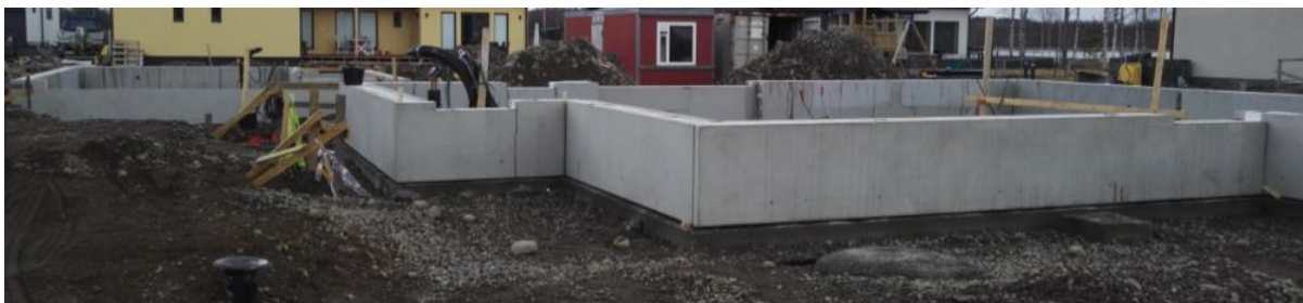
Kuva 11. Esimerkkikohteen perusmuurielementit paikalleen asennettuna. Kesä 2017
