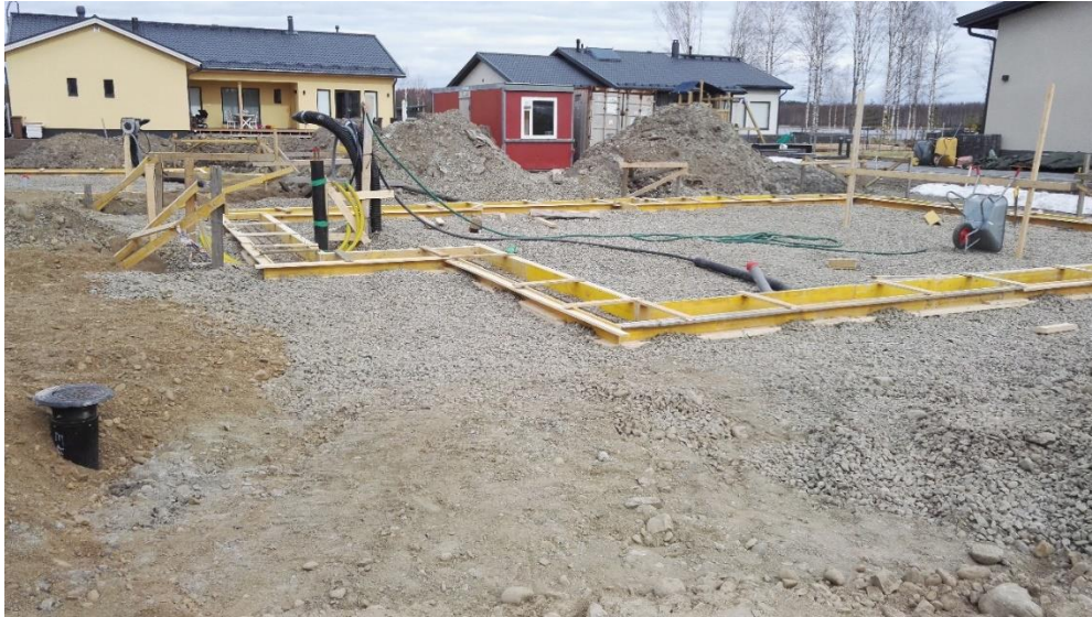
Kuva 4. Anturamuotti esimerkkitilanteessa, kesä 2017.
