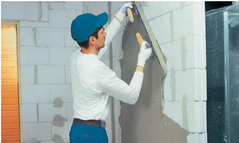
Kuva 29. Muurattu Kahi-väliseinäponttiseinä, jota tasoitetaan. [41]
