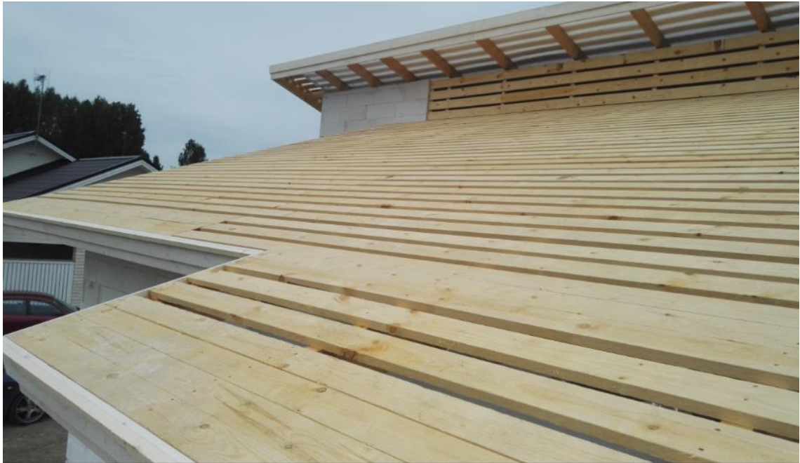
Kuva 26. Tällainen harvalaudoitus käy esimerkiksi kone- ja lukkosaumakatteille. Kuva kesältä 2017.
