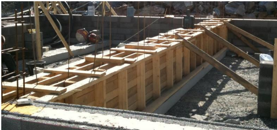
Kuva 7. Pientalon perusmuurin valumuotti laudasta tehtynä. [17]
