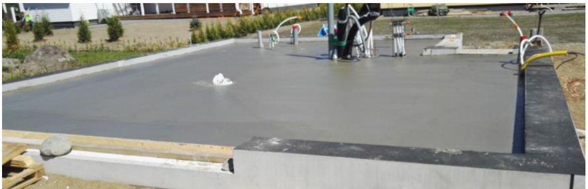
Kuva 17. Esimerkkikohteen autotallin lattia on vasta valettu. Kesä 2017
