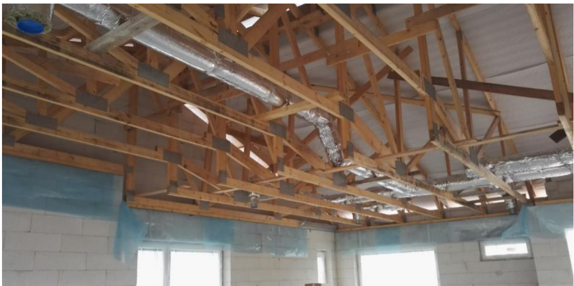
Kuva 24. Esimerkkikohteen kantavat kattoristikot. Kesä 2017.
