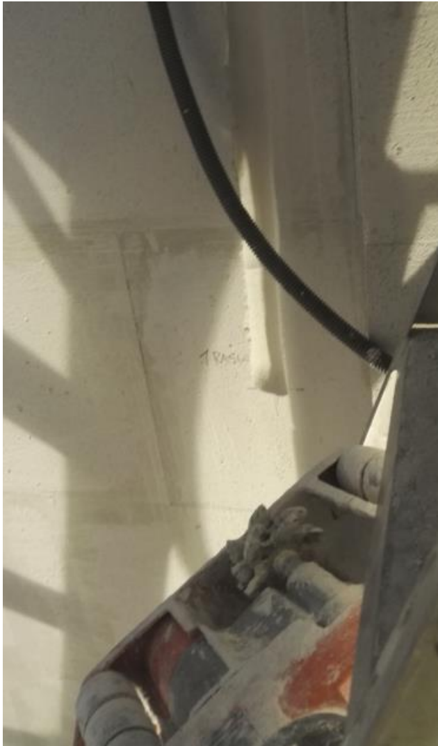
Kuva 31. Urituslaite ja sillä seinään tehty ura. Talvi 2017.
