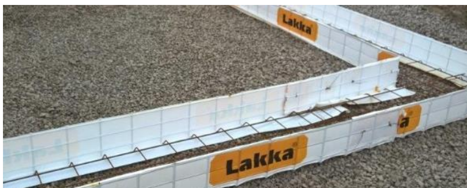
Kuva 4. Anturan valmismuotti asennettuna [8].
