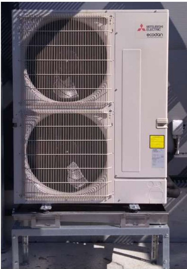
KUVA 9. Toteutuneen kohteen E ulkoyksikkö SHW160YKA
