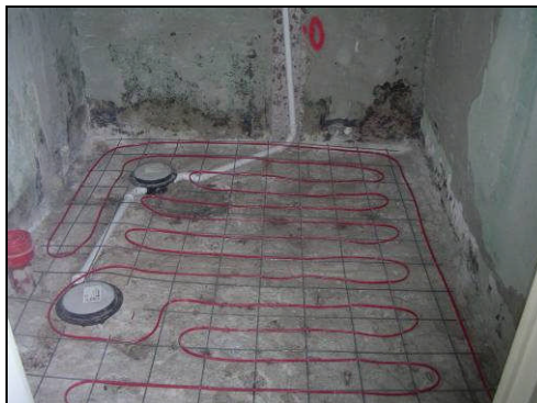
Kuva 15. Putkistokorjauksen yhteydessä märkätilan lattiaan asennettu sähkötoiminen lattialämmitys [22].
