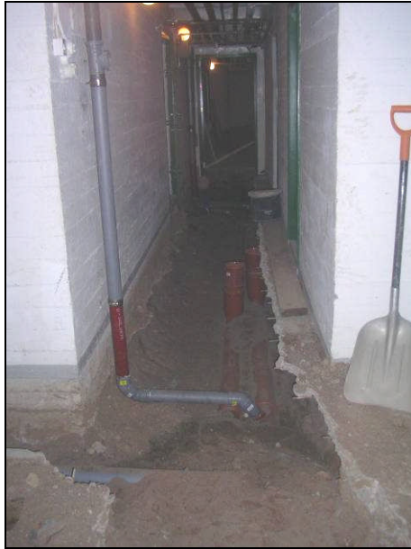
Kuvat 3 ja 4. Pohjaviemäriin uusimistyö käynnissä rakennuksen sisä- ja ulkopuolella [22].
