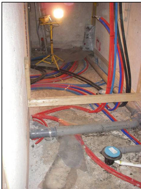
Kuvat 5 ja 6. Vesi- ja viemäriputkien uusimistyö käynnissä märkätiloissa [22].
