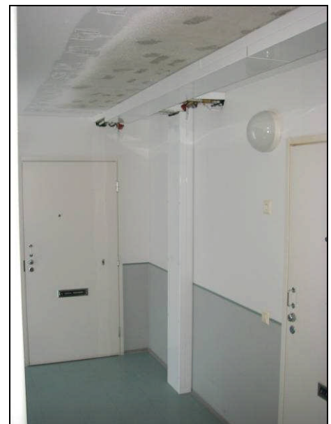
Kuvat 11 ja 12. Uudet vesijohdot asennettu porrashuoneeseen; asennus-/putkielementtikoteloratkaisu [22].
