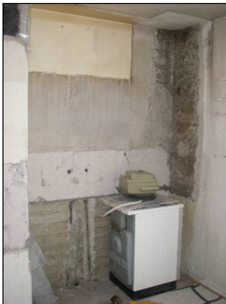
Kuvat 7 ja 8. Vesi- ja viemäriputkien uusimistyö käynnissä; kuva 7 asuntokeittiöstä (asunnossa ei tosin asuta remontin aikana) ja kuva 8 paloa osastoivaan rakenteeseen tehty läpivienti [22].
