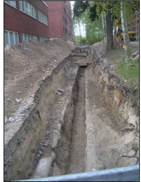
Kuvat 3 ja 4. Pohjaviemäriin uusimistyö käynnissä rakennuksen sisä- ja ulkopuolella [22].
