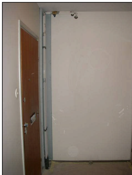
Kuvat 11 ja 12. Uudet vesijohdot asennettu porrashuoneeseen; asennus-/putkielementtikoteloratkaisu [22].
