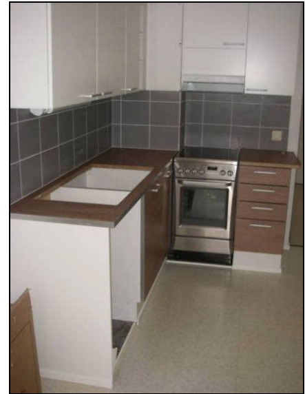
Kuvat 13 ja 14. Putkistokorjauksen yhteydessä suoritettavan keittiökalusteiden uusimistyö käynnissä [22].
