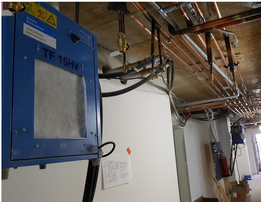
Kuva 25. Ylemmät kerrokset lämpenevät vaikka talotekniset työt ovat vielä vaiheessa.
