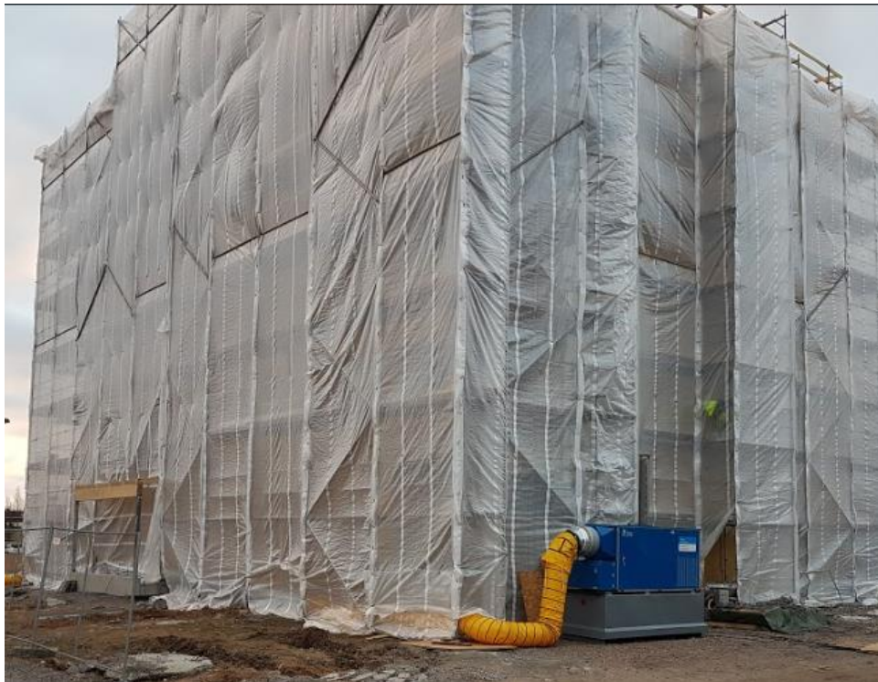
Kuva 17. Julkisivulämmitystä 195 kW tehoisella lämpöpuhaltimella.
