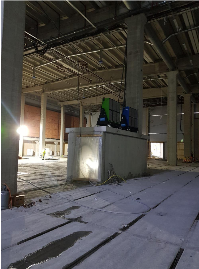
Kuva 28. 250 kW tehoiset lämpöpuhaltimet nostettu ylös lattiavalun edestä.
