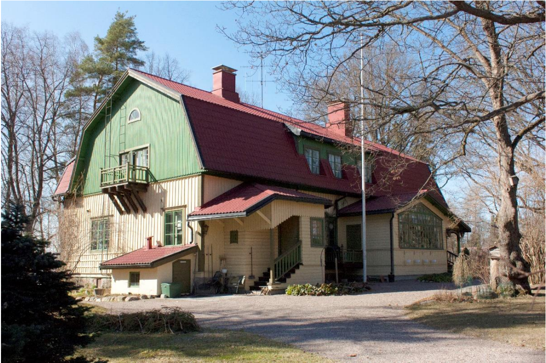
Kuvio 8. Suviranta 23.5.2018. Katto on pellistä ja keskimäinen savupiipuista on purettu.
