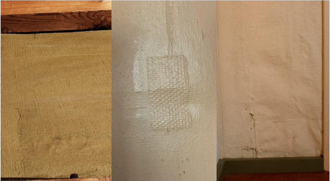
Kuvio 11. Esimerkkejä säkkikangastapettien paikkauksista. Vasemmassa kuvassa ateljeen vihreässä tapetissa sideharsopaikka, keskellä salissa lasikuitukangaspaikka ja oikealla makuuhuoneen tapetissa oleva säkkikangaspaikka.
