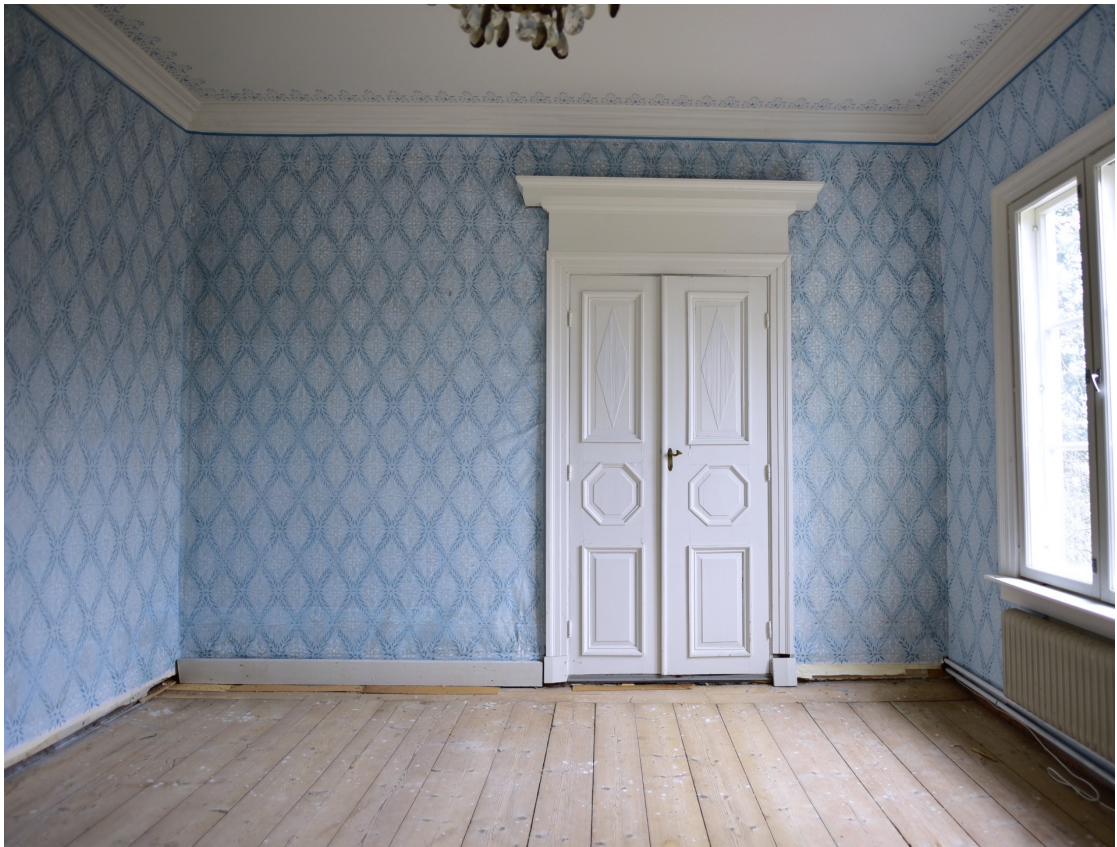
Kuvio 32. Valmis huone. Kattoon tehtiin samassa työrupeamassa alimmasta kerroksesta löytnyt sapluunakoristelu. Ikkunaseinällä näkyy rekonstruktio sileämpänä ja kirkkaampana kuin muut pinnat. Kuvasta puuttuu vielä jalkalistat, oven vasemmalle puolelle sovitettiin olemassa olevaa pätkää, jotta nähdään kuinka korjaukset asettuvat jalkalistaan nähdessä.
