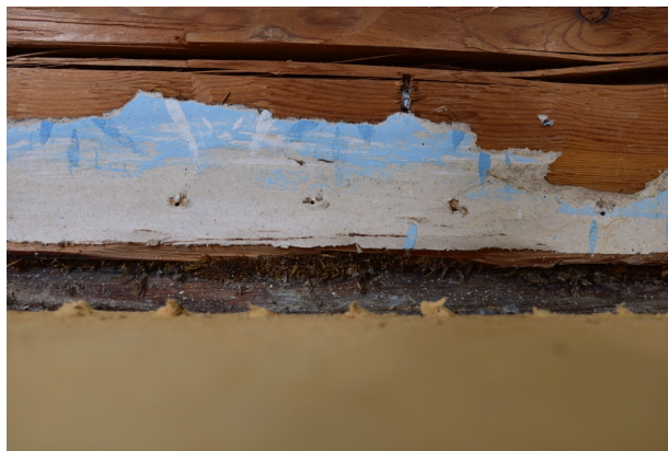
Kuvio 16. Jalkalistan alta löytyi alkuperäistä sinistä sävyä. Komerot ja listojen aluset ovat hyviä paikkoja löytää alkuperäisiä pintoja ja värejä. Pimeässä useimmat sävyt säilyvät muuttumattomina. Öljysideaineiset maalit taas kellastuvat voimakkaasti pimeässä.
