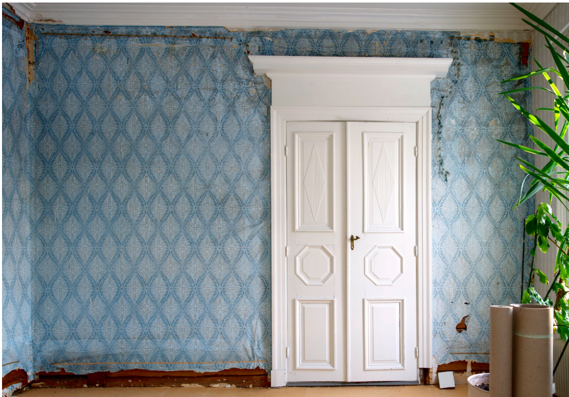
Kuvio 6. Sinisen förmaakin seinäpintaa työn alkaessa. Kolmipeiliset ovet heloineen ovat alkuperäiset. Yläpeileissä on rihlattu rombikuvio.
