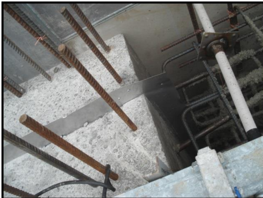
Kuva 30. Työsaumassa tartunnat ja tiivistystuotteita [13]
