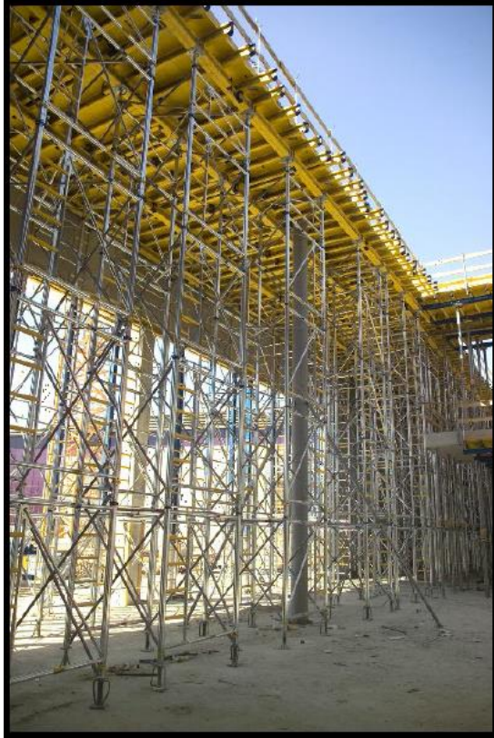
Kuva 8 Dokan tukitornimuottijärjestelmä. [8, s. 8]
