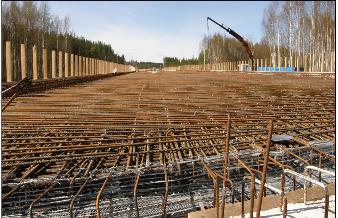
Kuva 32. Työsaumaverkko sidottuna kansirakenteen pätyyn. [32]
