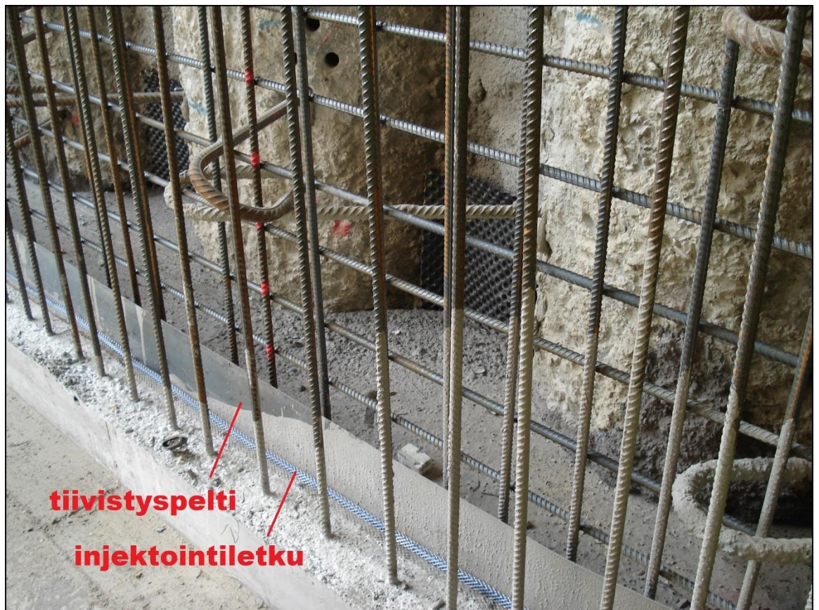
Kuva 30. Työsaumassa tartunnat ja tiivistystuotteita [13]
