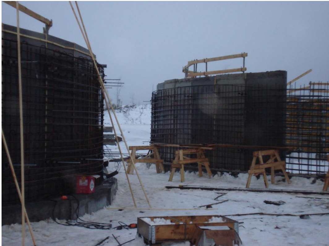
Kuva 18. Järjestelmämuotin avulla toteutettu kaareva seinä, jossa kasettien välissä on puusovitekiilat. [13]
