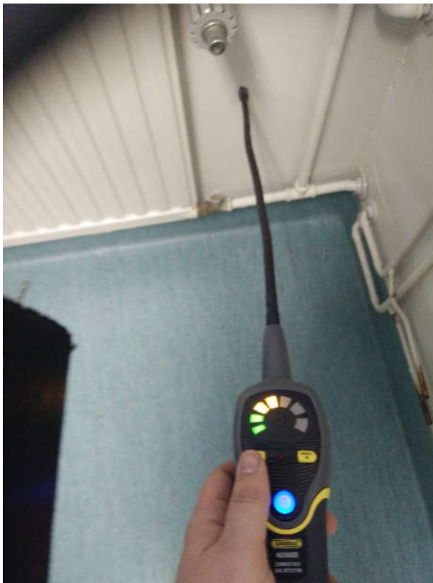
Kuva 25. Alapohjaan syötetty merkkiaine näkyy ulkoseinärakenteeseen poratussa reiässä. Alapohjan ja ulkoseinän välillä on siis varmulla ilmayhteys.
