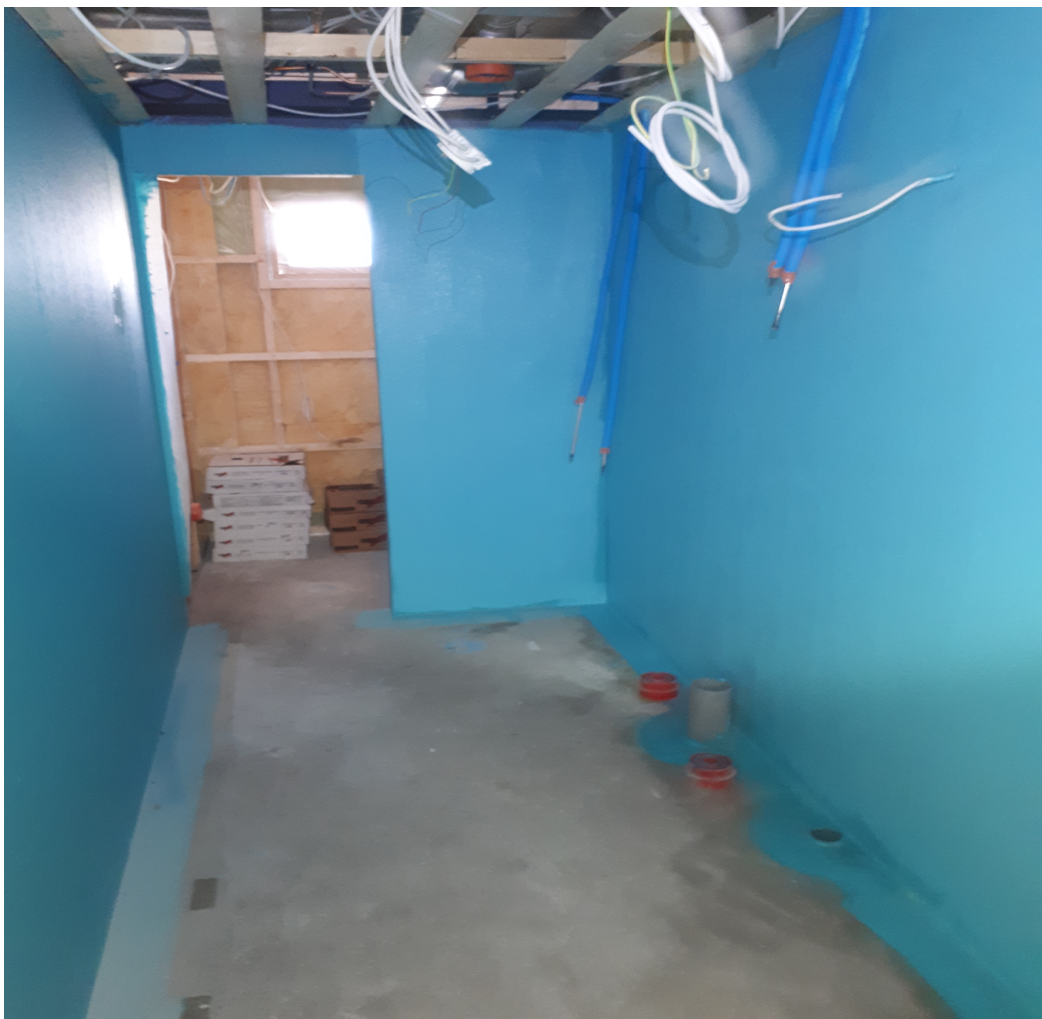
Kuva 4. Seinät vesieristettynä.
