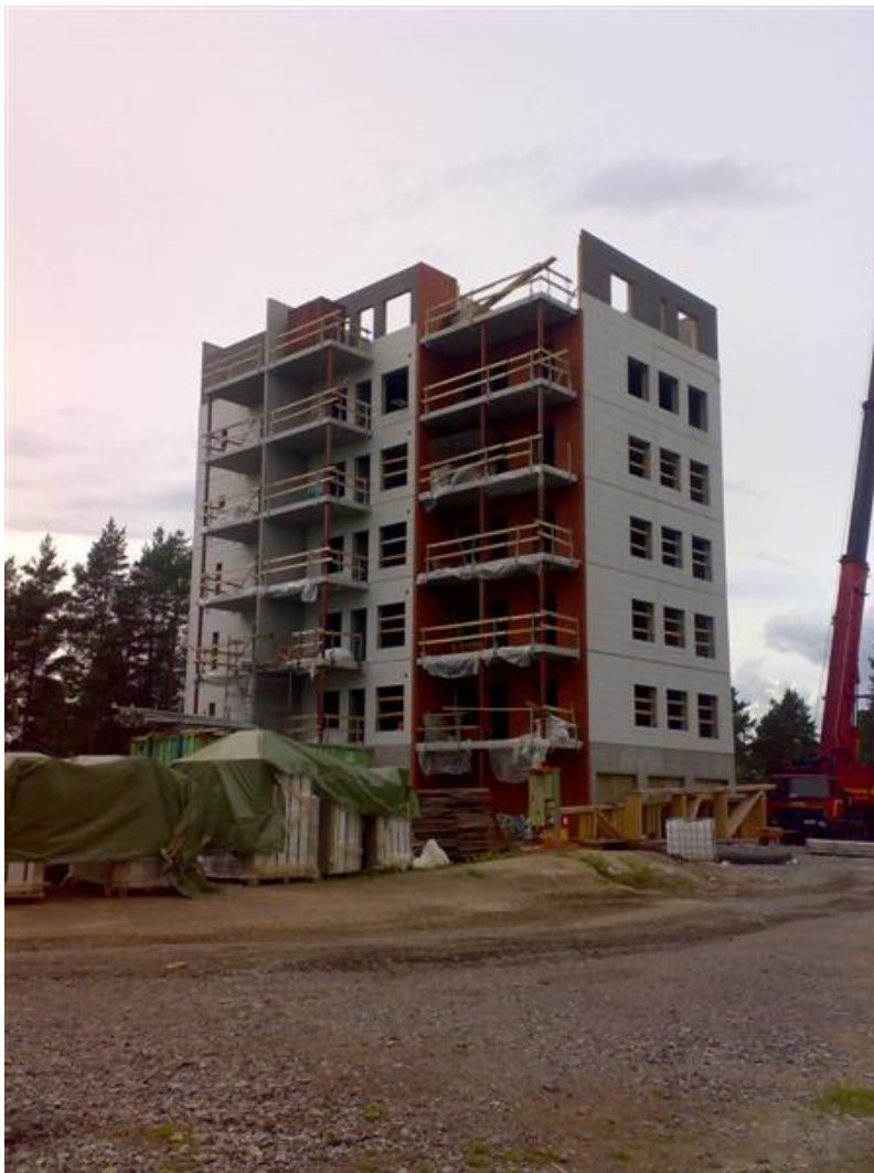
Kuva 4. Kerrostalon putoamisuojaus hoidettu puisilla kaiteilla ja metallisilla tolilla.
