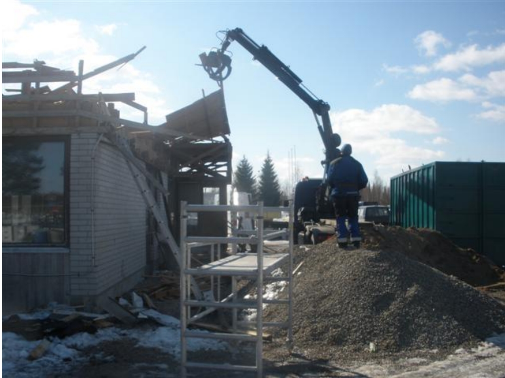
Kuva 6. Vesikatonpurkutyötä koneen avulla.
