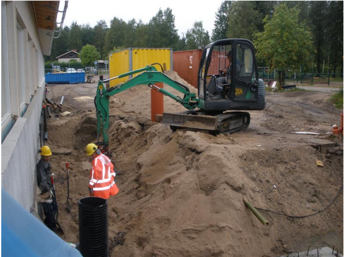
Kuva 9. Maankaivuussa käytetään kypärää, huomioväritystä ja kuulosuojaimia.
