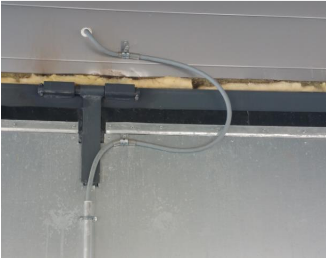
Kuva 10. Kaapeliin tehty silmukka, jolla vähennetään kaapelin rasiitusta.
