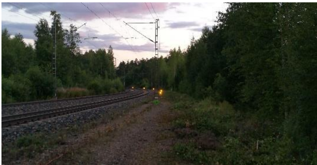
Kuva 29. Kaarteessa sijaitseva työmaa-alue. Järjestelmän hälyttimien asettelu ja hälytyksen merkkivalo. (Holopainen 2017)
