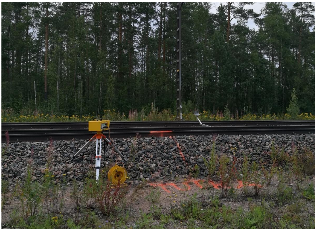
Kuva 33. Tulokynnys ja sen sijainti merkittynä havaitsemisen helpottamiseksi asennuksen yhteydessä. (Holopainen 2017)
