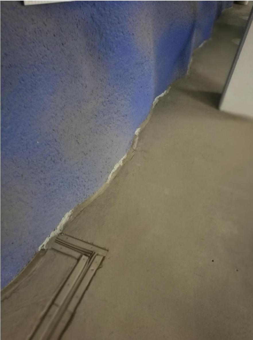
Kuva 2. Saumoja on yritetty korjata uudelleen kittamalla, mutta se ei ole ollut toimiva ratkaisu.
