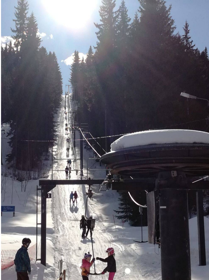
Kuva 1. Pääskyvuoren Vintertec VM 45 ankkurihissi.
