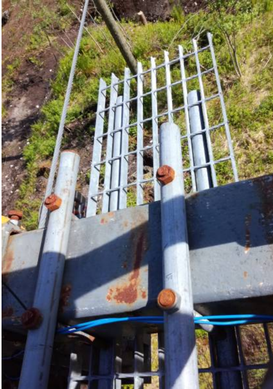
Kuva 9. Koltek-hissin 1. pylvään työtaso.
