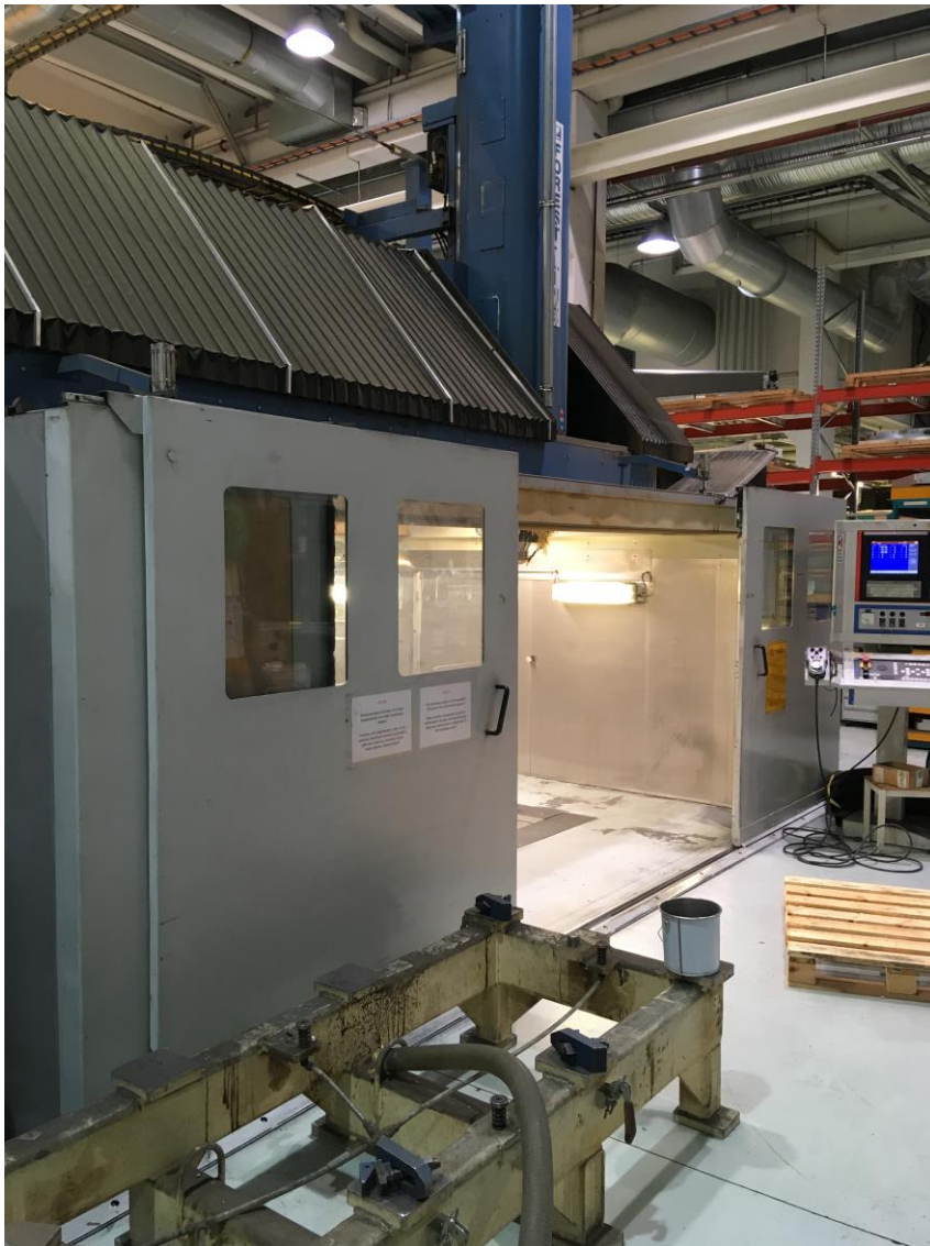
KUVA 44. Forest-Liné. Kara oli kuvanottohetkellä X-akselin alkupäässä. Kara ja Z-akseli on sininen pylväsrakenne
