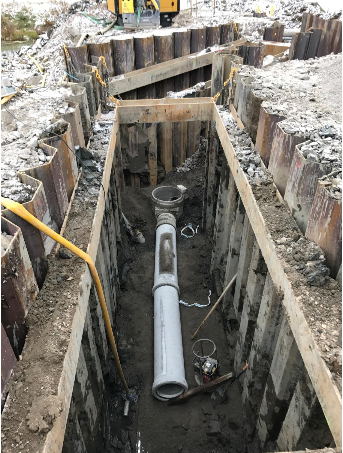
Kuva 2. Ponttiseinällä tuettu kaivanto.
