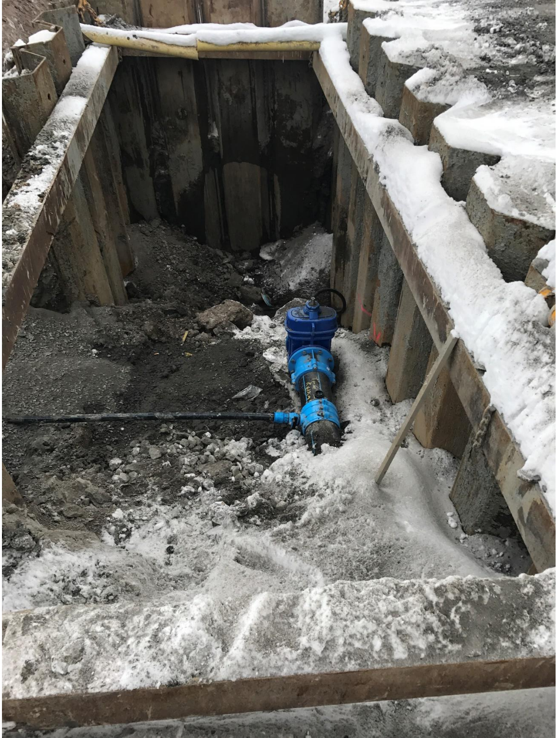
Kuva 3. Vesijohtoa ja toimilaitteita asennettuna tuetussa kaivannossa.
