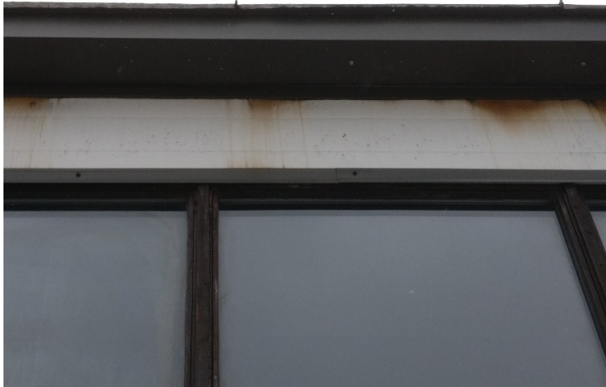
Kuva 16. Seinäelementin ja kattoelementin liitos sivuräystäällä.
