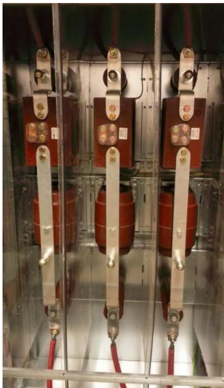
Kuva 30. KJ-virtamuuntajat (ylhällä) ja jännitemuuntajat (alhaalla)
