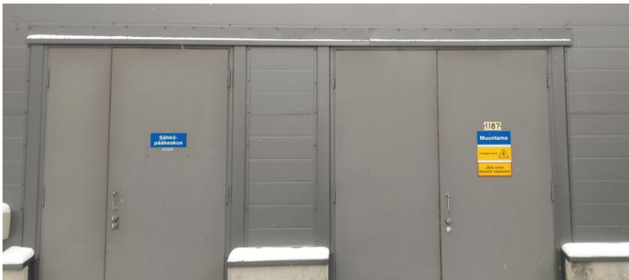
Kuva 28. Teollisuushallin sisäänkäynnit sähkötiloihin
