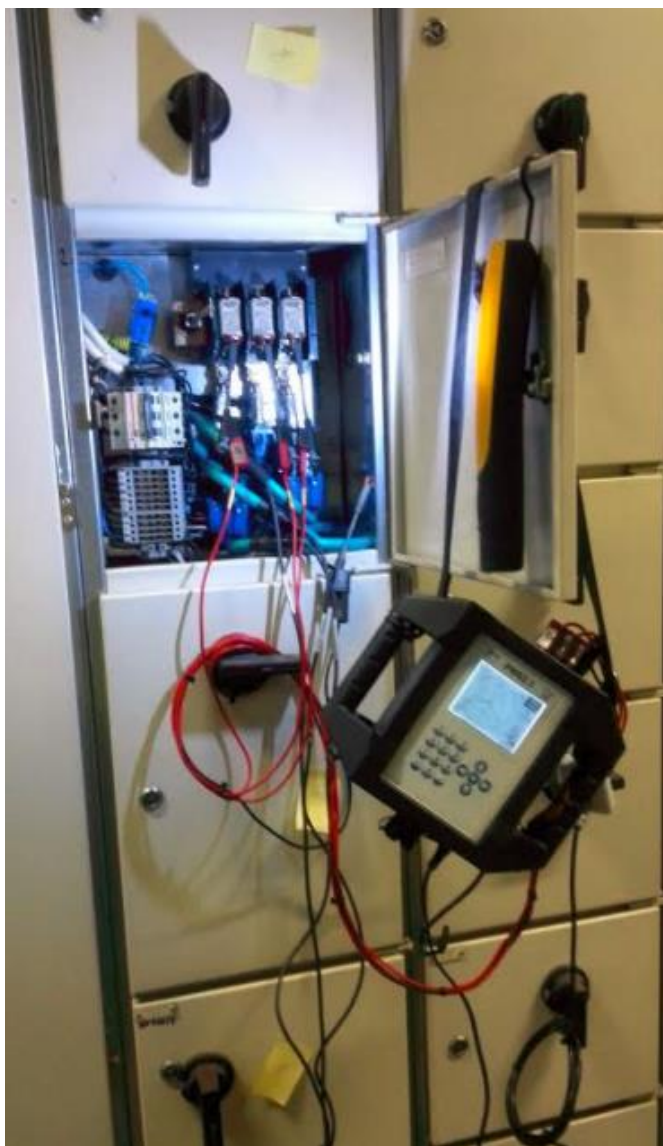
Kuva 17. PWS kytkettynä mittauspiiriin
