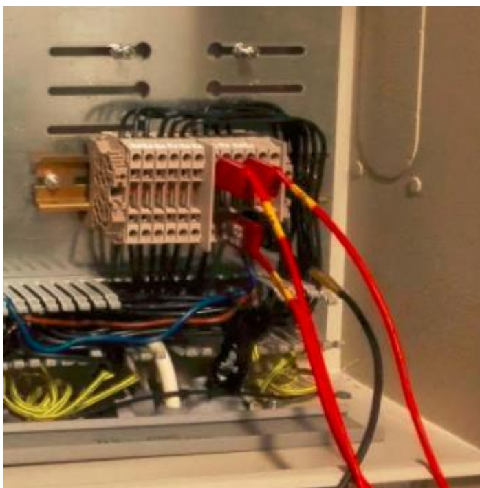
Kuva 35. Toision riviliittimet. PWS kytketty mittauksen jänniteriviliittimiin
