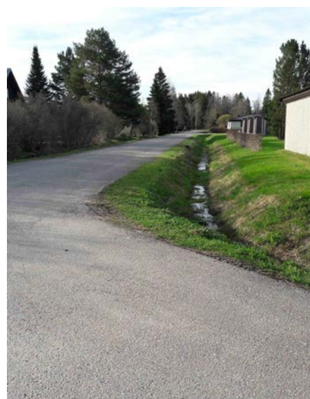
KUVA 2. Vanhan asuinalueen hulevesiä ohjataan avo-ojissa.
