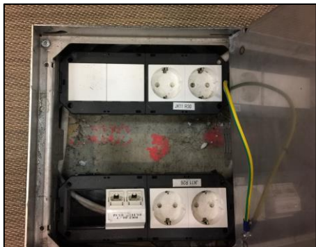
Kuva 7. Ballroom kytkentärasiat lattiassa
