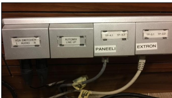
Kuva 8. Ballroom kytkentäpisteitä seinässä
