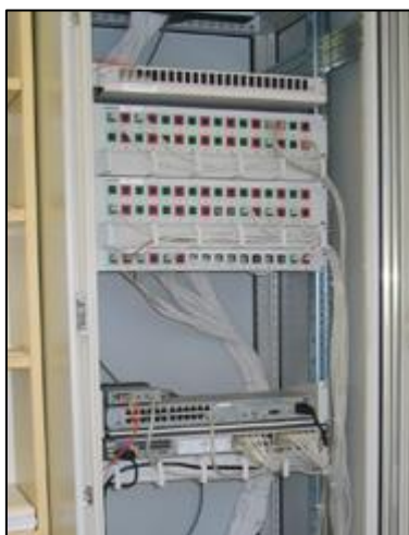
Kuva 11. Esimerkki ristikytkentäkaapista (Hannu Backman Oy 2018)
