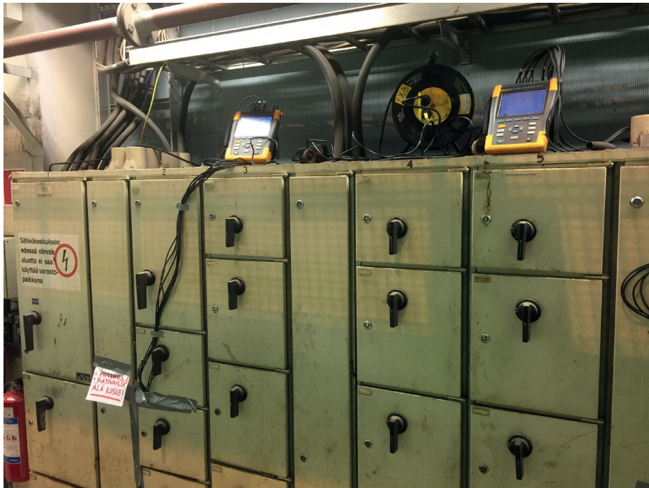
Kuva 9. Sähkönlaadunanalysointilaitteella, Fluke 435 II, mitataan sähkötehoa hankkeen kohteessa. Mittausjakso voidaan toteuttaa hetkellisenä otantana tai pitkäaikaisena seurantaan (kuva Eveliina Kuokkanen).
