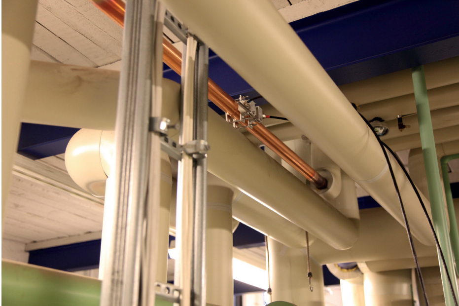
Kuva 7. Ultraääneen perustuvan virtausmittarin (Intra) anturit asennettuna putken pinnalla (kuva Eveliina Kuokkanen).
