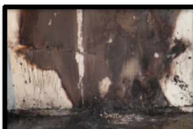
Kuva 7. Kuva raivaamisen jälkeen, jossa palojäljet ovat selkeästi näkyvissä.
