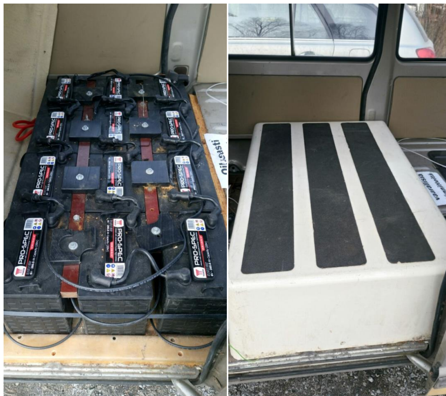
KUVA 4. Ajoakusto ja eristetty kotelo (Kuva: Lauri Helminen 2017)
