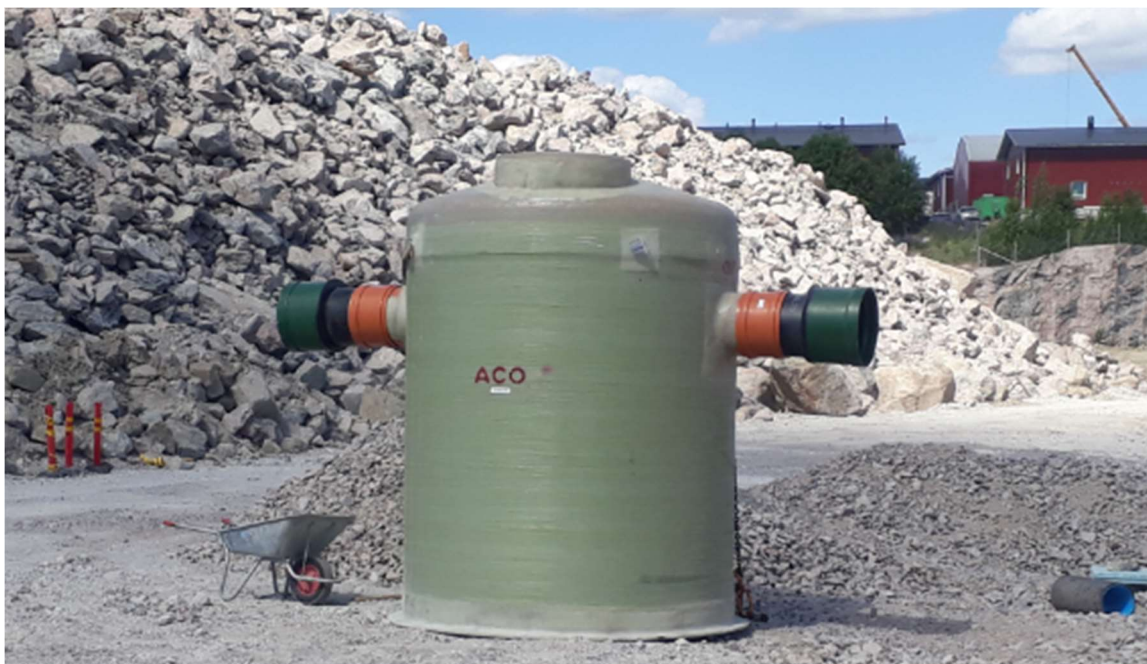
Kuva 10 Kuvassa on ensimmäisenä asennettu kaivo 2 ennen asennusta. Kuvan ottamisen jälkeen kaivo nostettiin kaivinkoneella nostolenkkejä apuna käyttäen kaivannossa olevalle asennusalustalle. (Kuva Teemu Björkbackan itse ottama)
