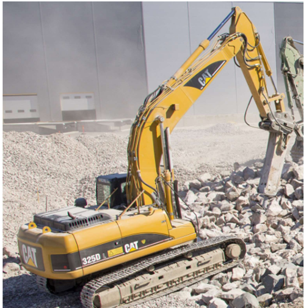
Kuva 9 Kivien halkaisua kaivinkoneeseen liitettävän hydraulisen iskuvasaran, ammatistilangissa rammerin, avulla. Kuvan konetta ja iskuvasaraa käytettiin kaivo 2:n kohdalla olleen korkean kalliopinnan louhimiseen tässä työssä kuvailussa asennustyössä. (Kuva: Louhintahiekka)
