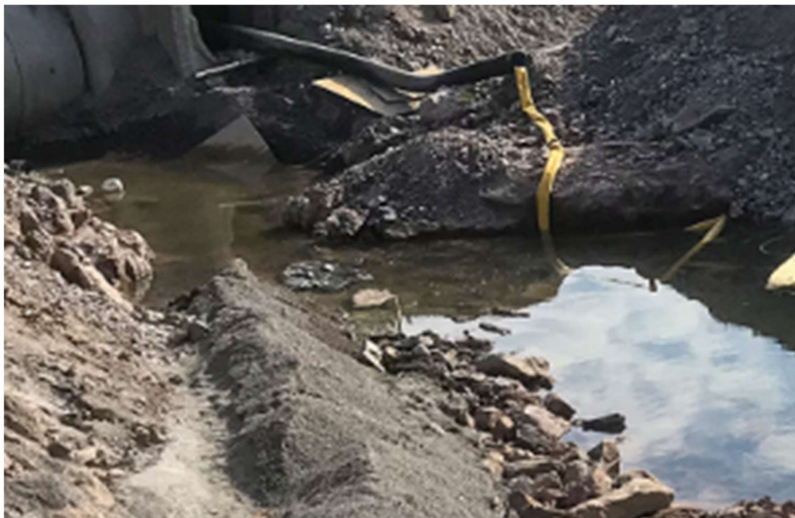
Kuva 6 Kaivo 2:n kaivannon olosuhteita keväällä ennen asennustyötä. (Kuva Louhintahiekka)
