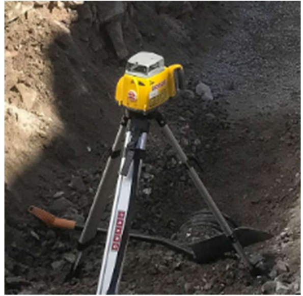
Kuva 8 Työssä korkojen ja kaatojen mittaamiseen käytetty tasolaser. (Kuva: Louhintahiekka)
