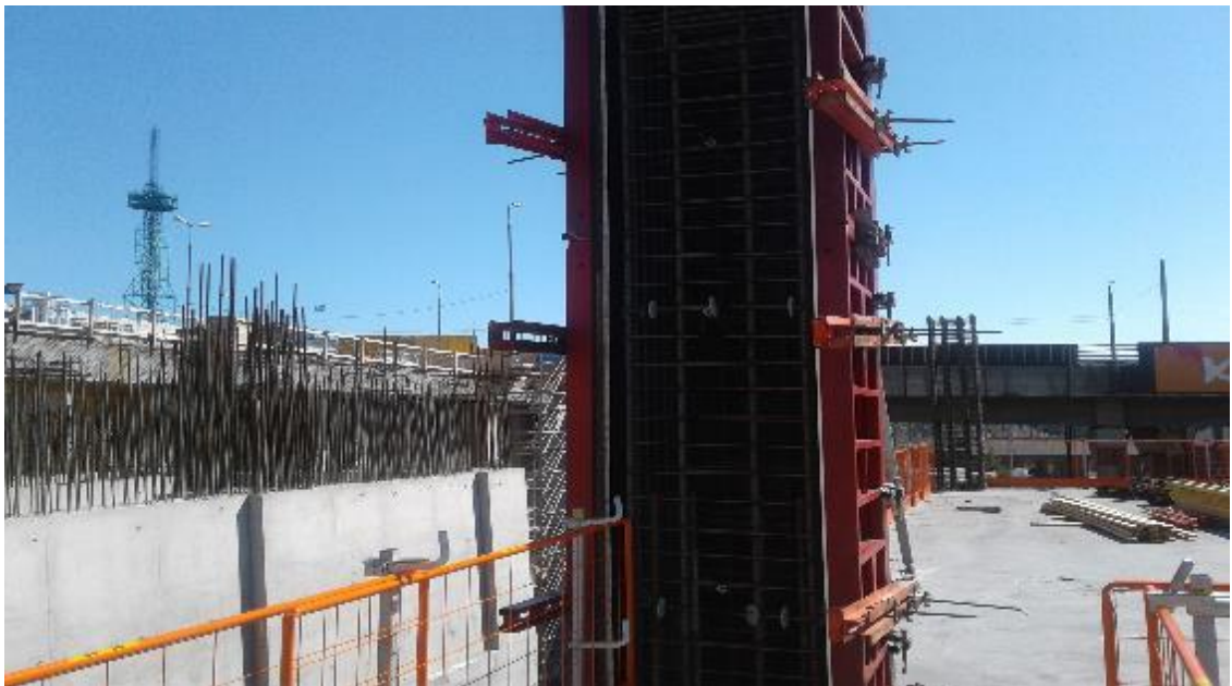
Kuva 5 Pilarin kasettimuotti
