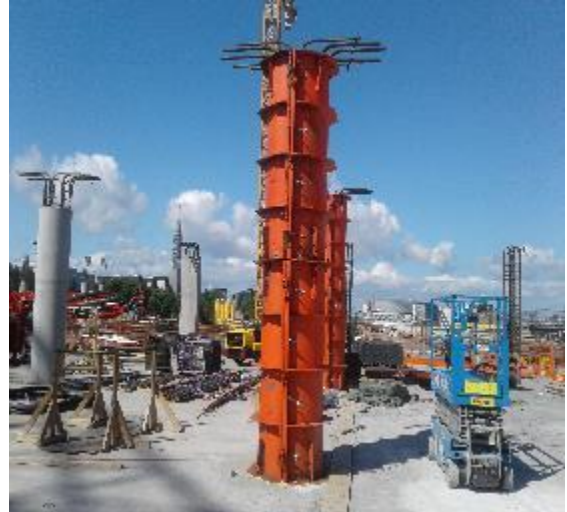
Kuva 5 Pilarimuotti kasattuna (taustalla valettuja pilareja)
