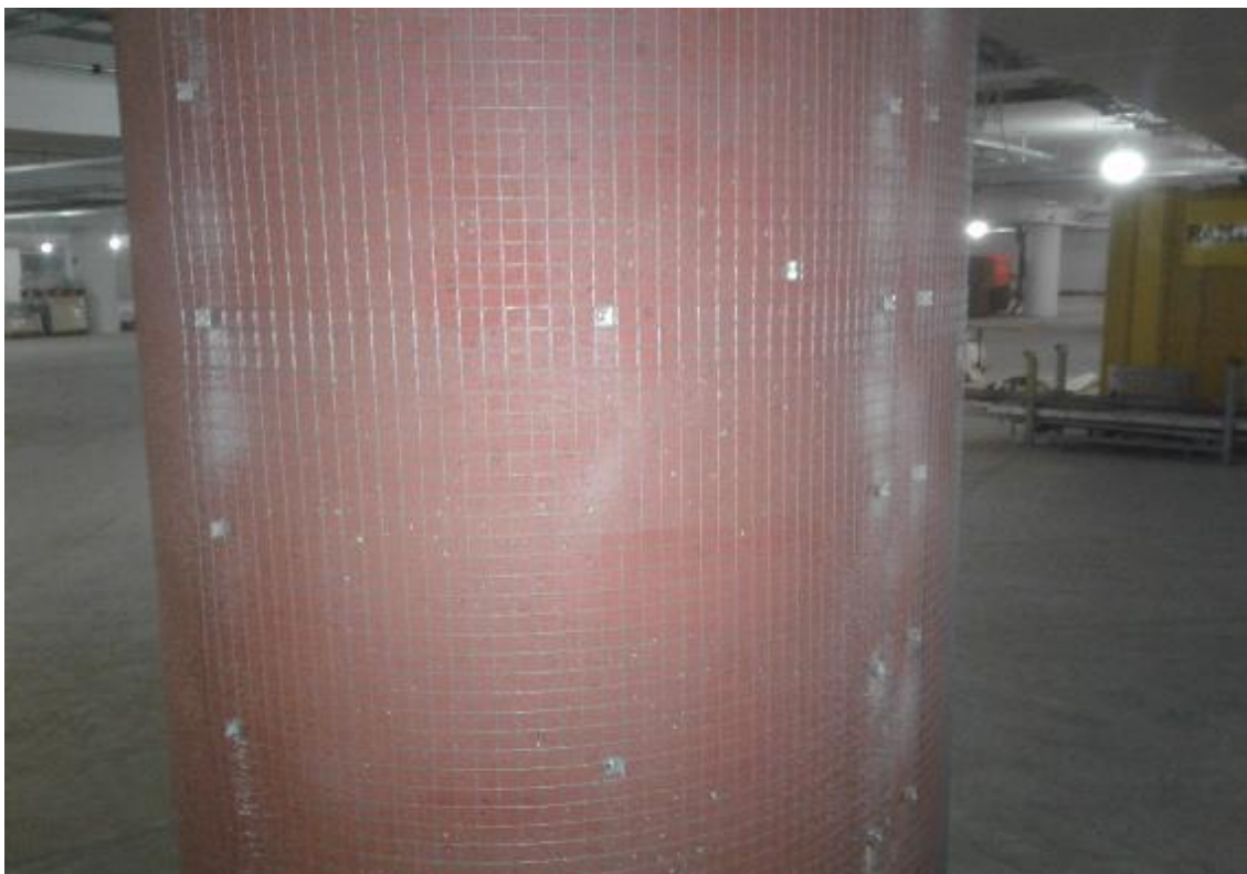
Kuva 17 Pilari valmiina rappausta varten
