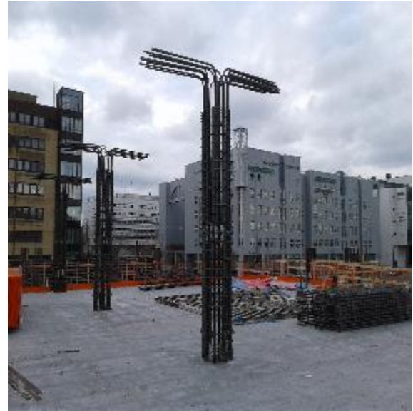
Kuva 4 Valmiiksi asennetut pilarien raudoitushäkit
