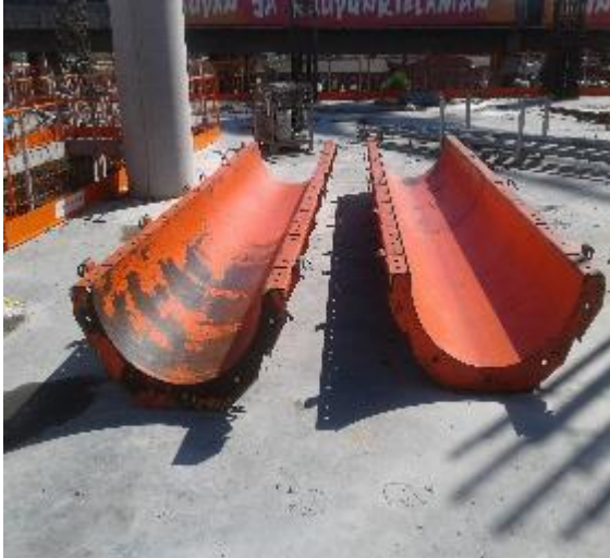
Kuva 4 Pilarin teräsmuotti
