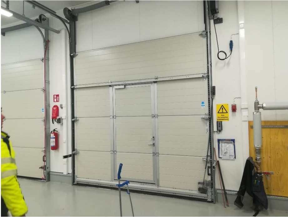
KUVA 3. Koneiden varastointitila. Varastointitilat sijaitsevat rakennuksen lännen puoleisessa päädyssä.
