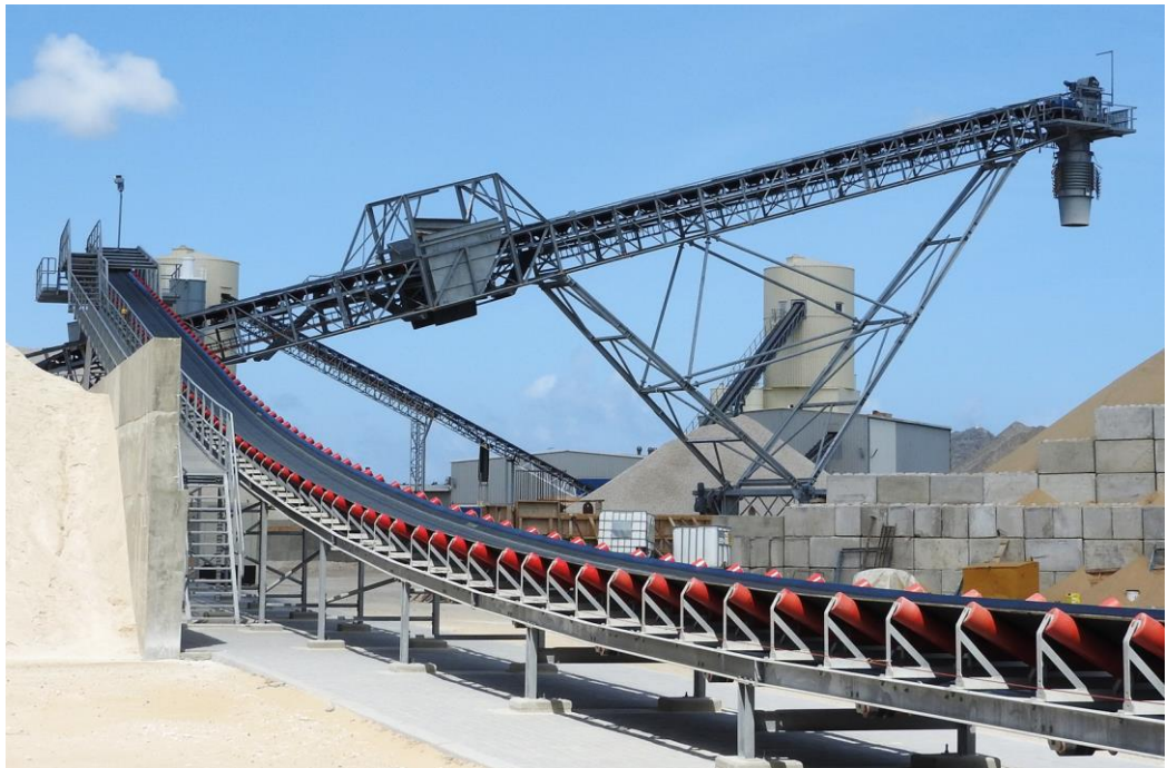
KUVA 2. Palkki- ja ristikkorakenteiset kuljetinrungot. (N.M. Heilig 2018)
