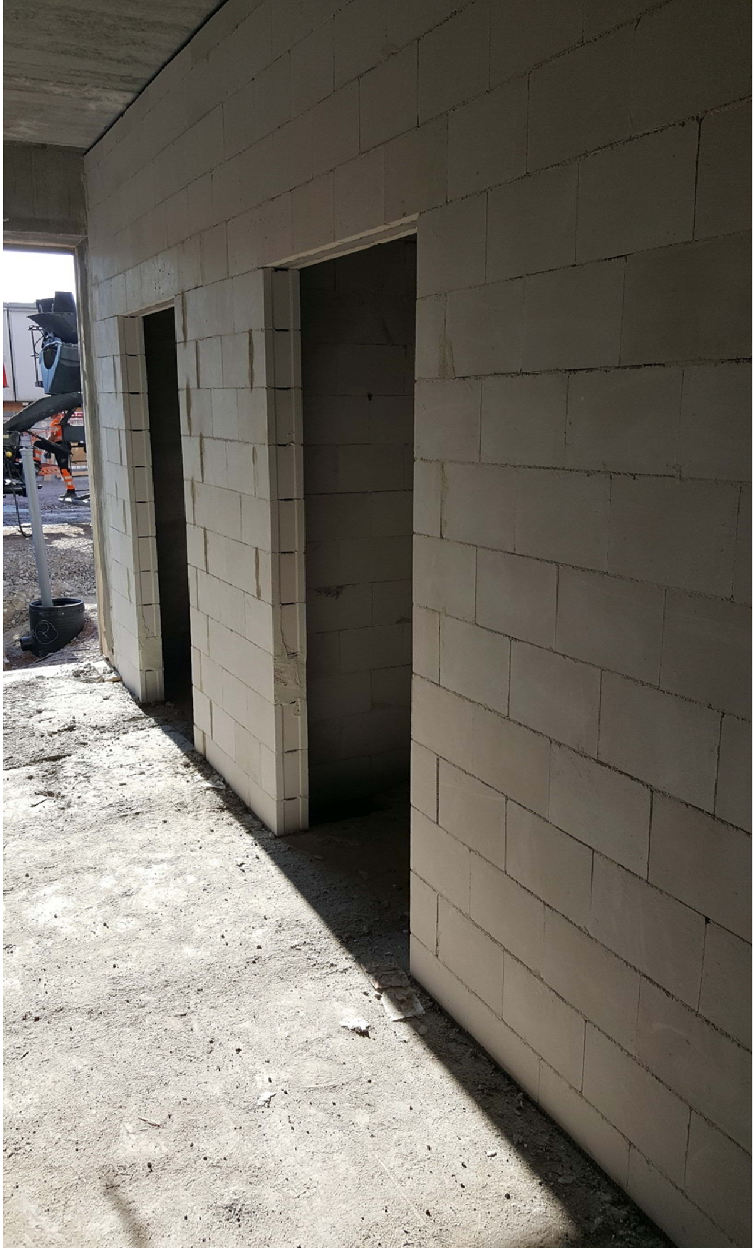
Kuva 5. Valmiiksi muurattu Kahi-harkkoseinä paikkauksineen.
