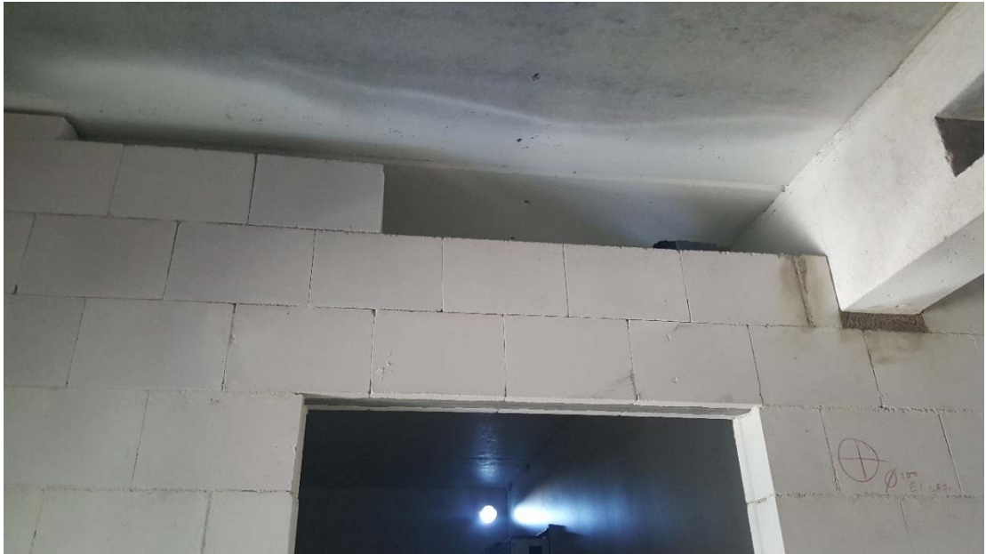
Kuva 3. Oviaukon ylitys palkilla ja ontelolaatan ja muurauksen välinen rako.
