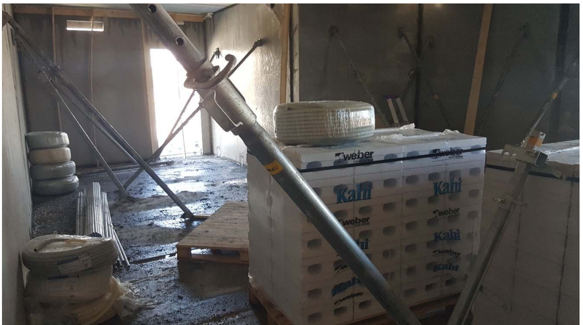
Kuva 2. Täsmätoimituksena nostetut harkkoletkat kerroksessa
