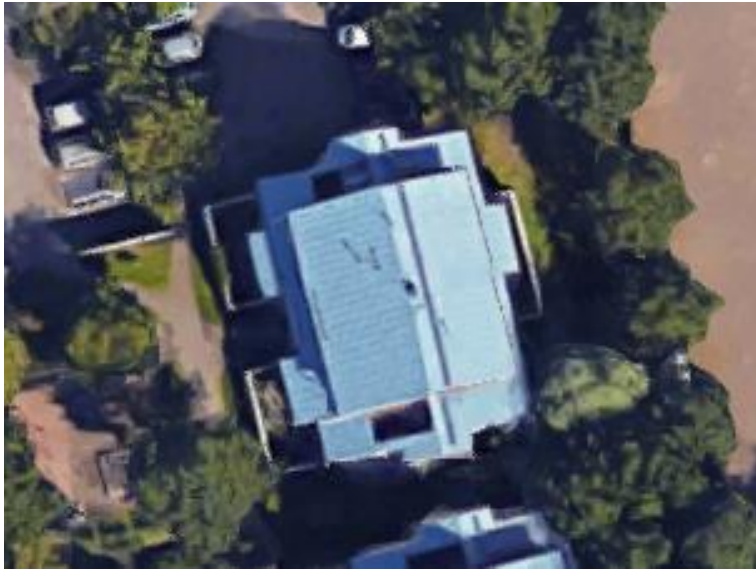
Kuva 10. Esimerkkikiinteistö ilmakuvassa (Google maps.)
