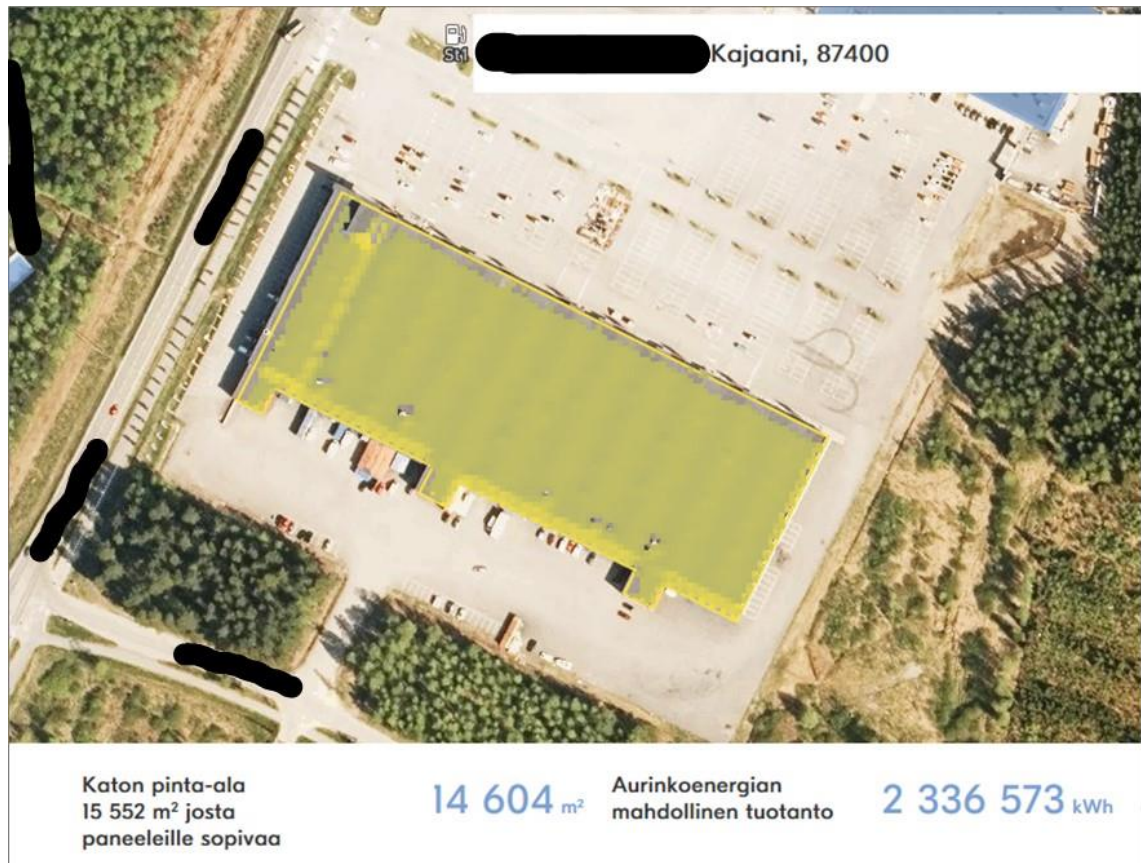
Kuva 23. Kuvakaappaus Fortumin laskimen aurinkosähköpotentiaalista Kajaanissa sijaitsevalle kiinteistölle. (Fortum 2018)
