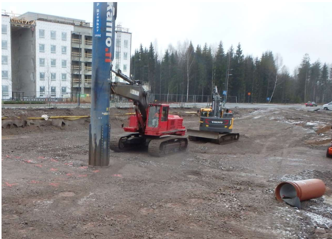
Kuva 9. Huhtakallion tiivistyskalusto Molskotin työmaalla. /16/
