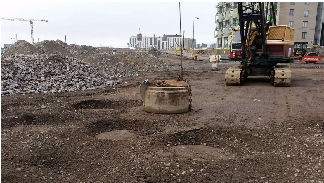
Kuva 4. Pudotustiivistystä Jätkäsaaren liikuntapuiston esirakentamisvaiheessa. /12/
