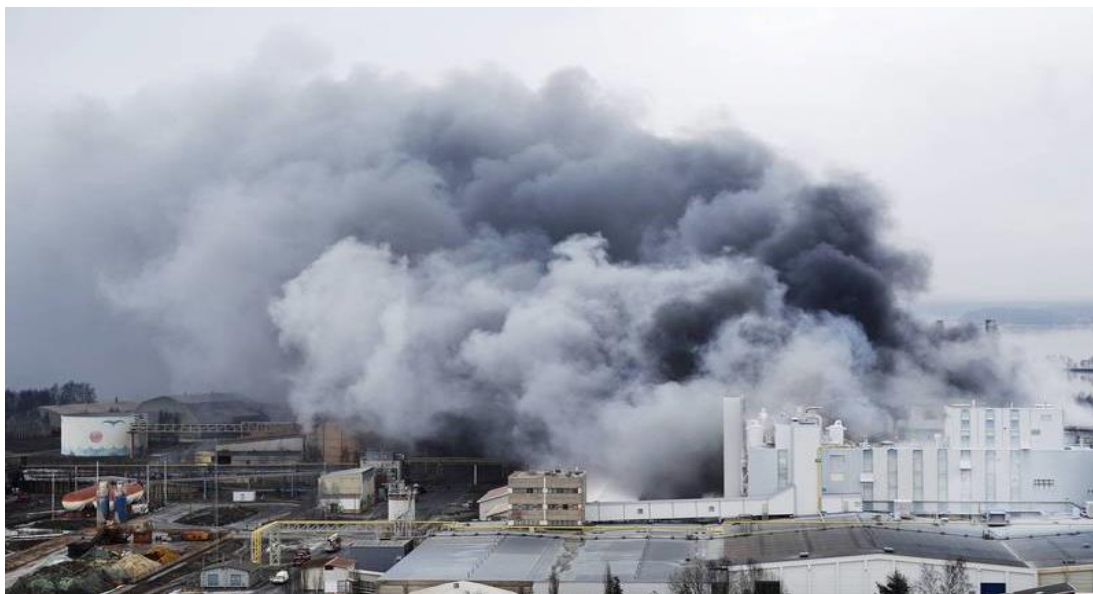
Kuva 1. Tulipalon aiheuttama savunmuodostus kuvattuna 30.1.2017 Kaanaan vesitornista (Hanna Laasanen 2017, 1)
