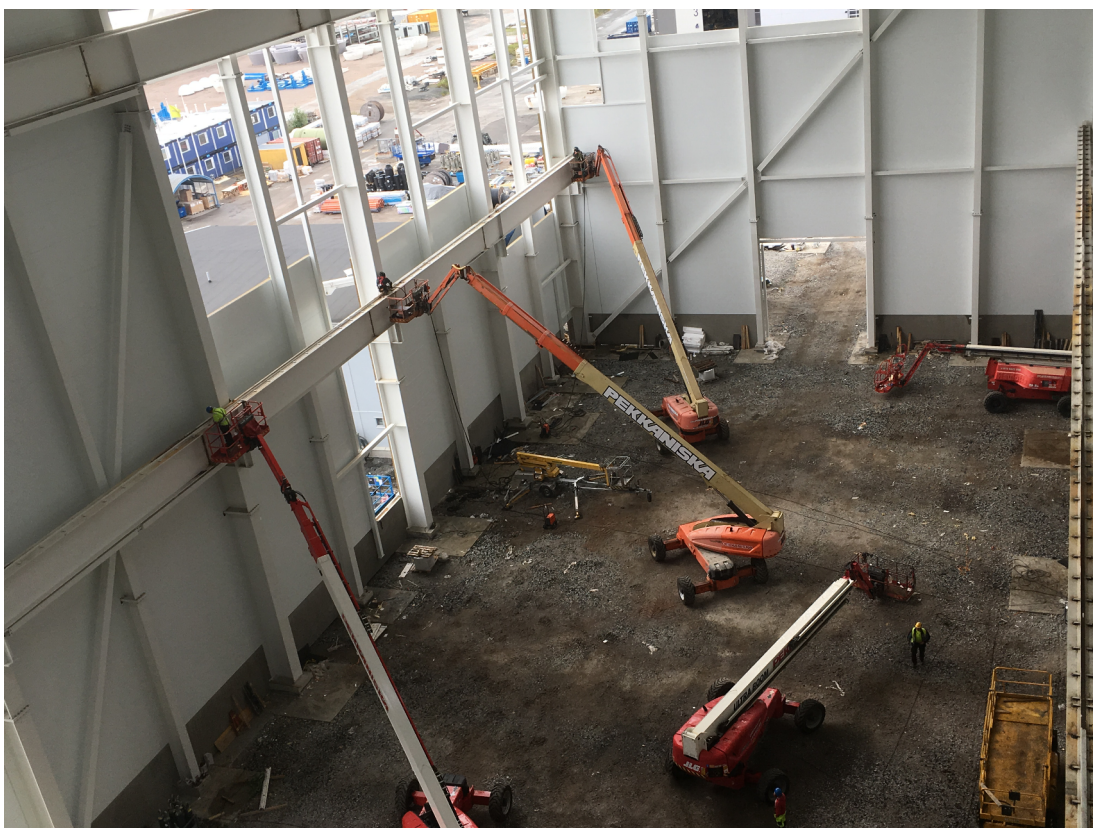
Kuva 2. Uuden kokoonpanohallin nosturiratapalkin asennus käynnissä.
