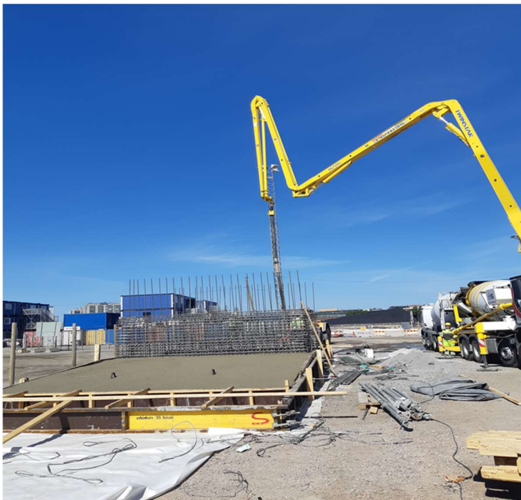
Kuva 7. Elementin pohjalaatan betonointi käynnissä. Kuva Otto Miettinen, Kreate Oy.
