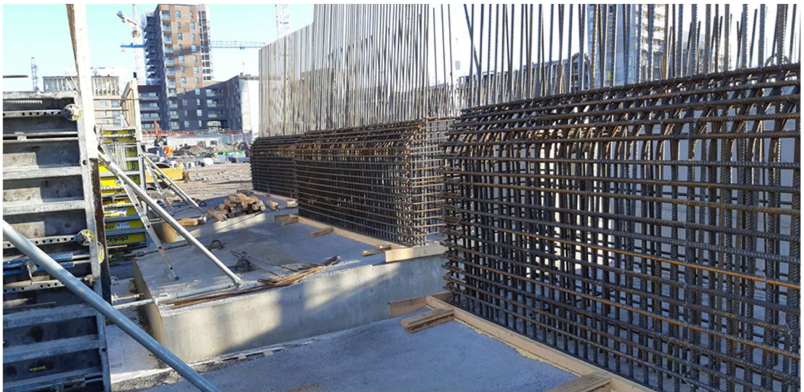
Kuva 8. AL-elementtien seinäraudoituksia. Kuva Otto Miettinen, Kreate Oy.
