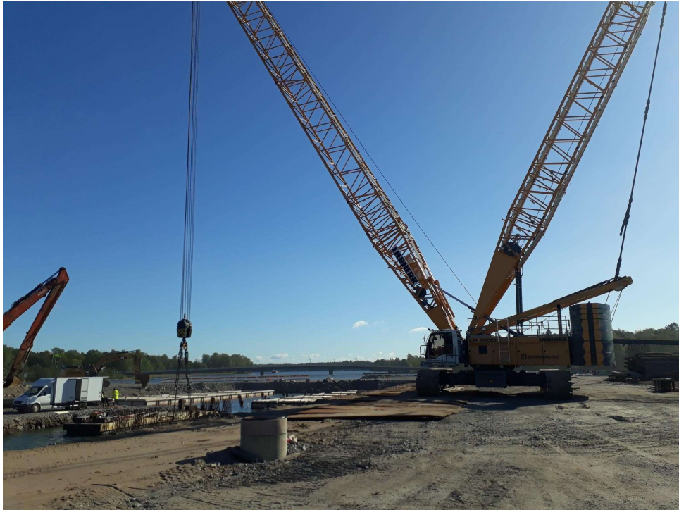
Kuva 10. Elementtien nostoissa Sompasaaren työmaalla käytetty Liebherr LR 1300 telialustainen mobiilnosturi. Kuva Vertti Eloranta.
