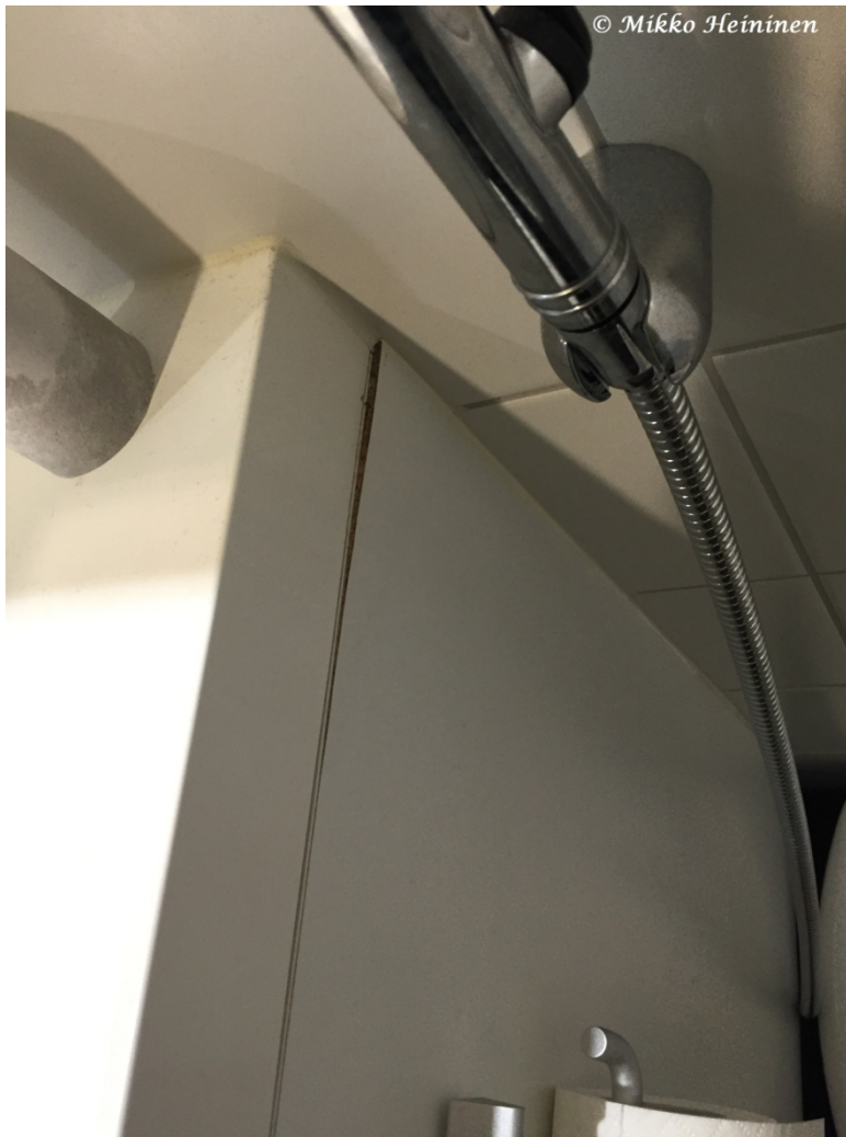
Kuva 6. Kylpyhuoneenkalusteen kosteusvaurio
