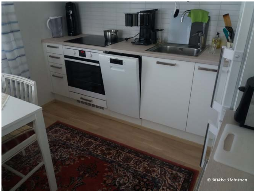
Kuva 4. Uuni vinossa, oven värivirhe ja uuninaluslaatikon sulkeutuminen
