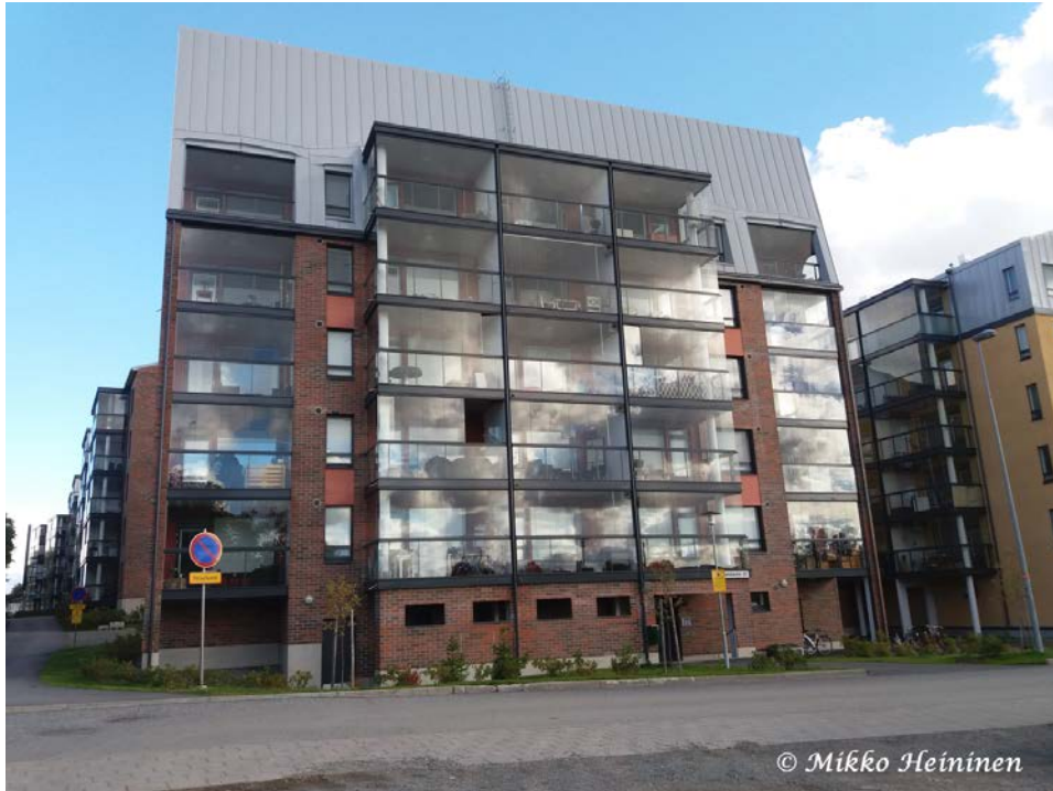
Kuva 1. Asunto Oy Turun Tyykin julkisivu
