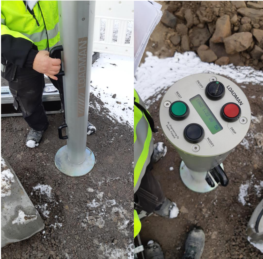
Kuva 5. Putkiarinoiden tiiveysasteen mittaus Loadman- pudotuspainolaitteella.
