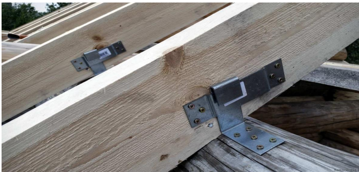
Figur 19. Glidjärn installerade på översta stockvarvet som håller takbalkarna på plats. (Saunologia, 2018)
