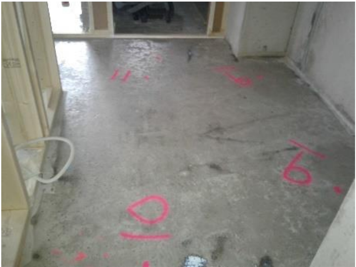
Kuva 39. Kustannustehokas pintabetonointi 9–11 mm (Forselius, A. 2018)
