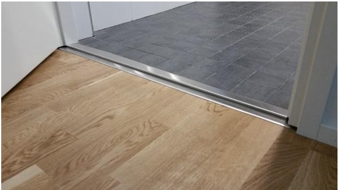
Kuva 14. Pesuhuoneen kynnyks, käytävä (Forselius, A. 2018)
