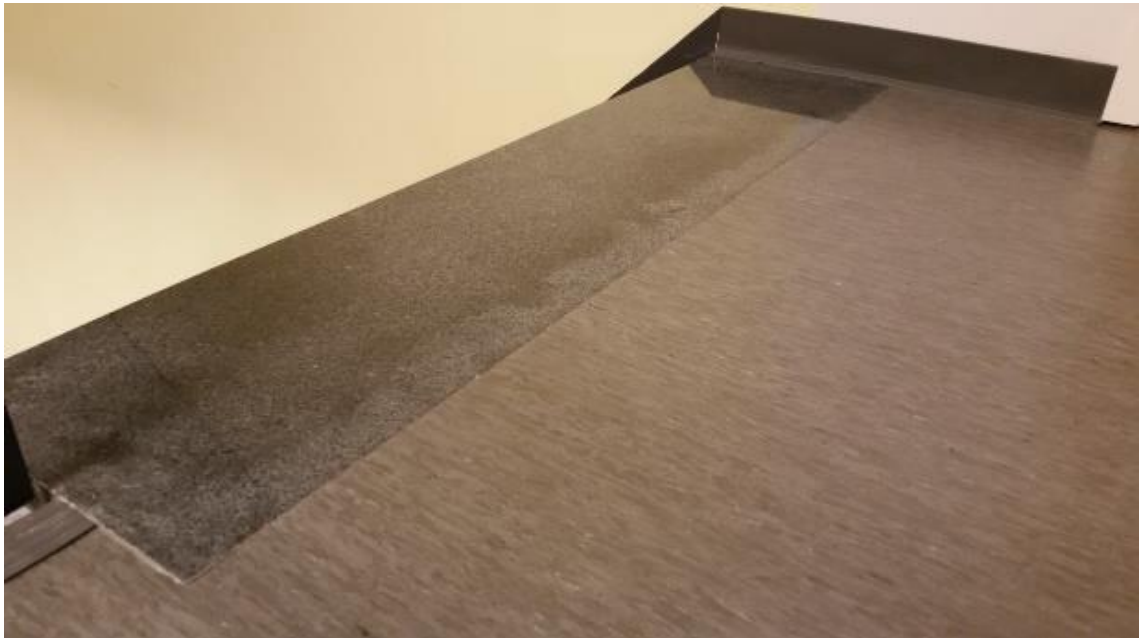
Kuva 30. Kynnyksetön elementtien liitos (Forselius, A. 2018)
