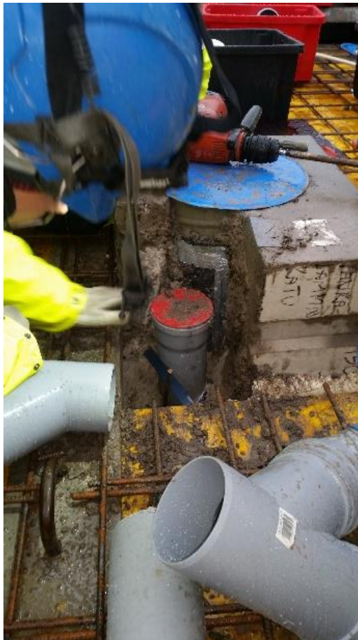
Kuva 34. Auki leikattu tekniikkahormi (Forselius, A. 2018)
