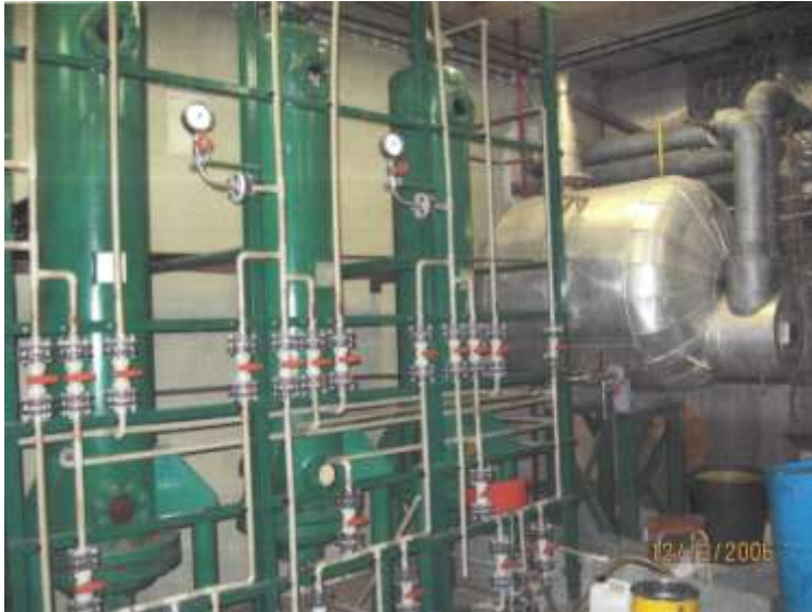
KUVA 1. ReCLog Oy:n ioninvaihtolaitteisto. (Kuva: Pekka Majamäki 2006)
