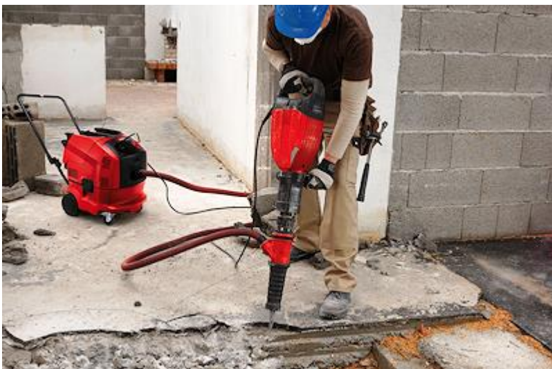
Bild 1: Pikning av betong med punktutsug (rakennuskone.fi)
