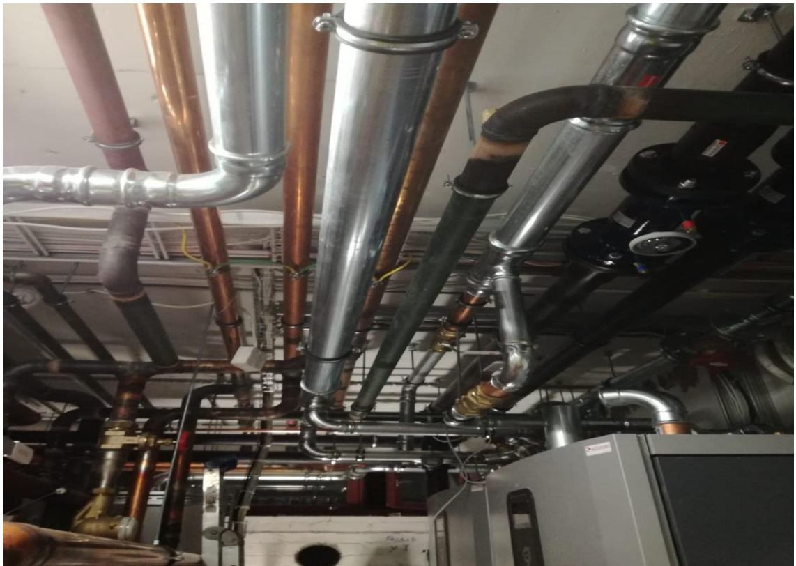
Kuva 4. Ahtaat tilat putkistoille (kuva: Marko Makkonen 2018)
