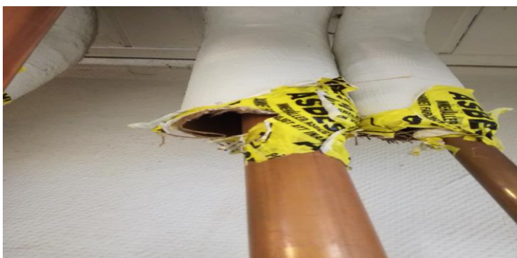
Kuva 6. Vuotava asbestieriste (kuva: Marko Makkonen 2018)
