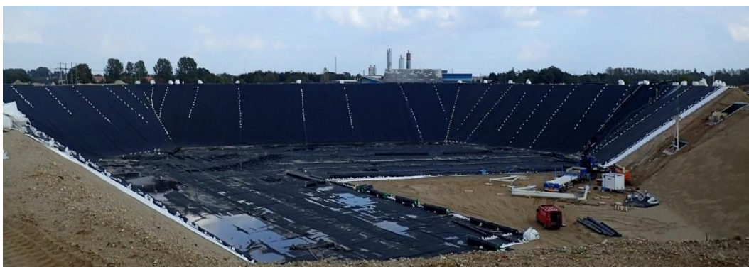
Kuvio 4. Kuva Vojensin kaivantolämpövarastosta. /8/
